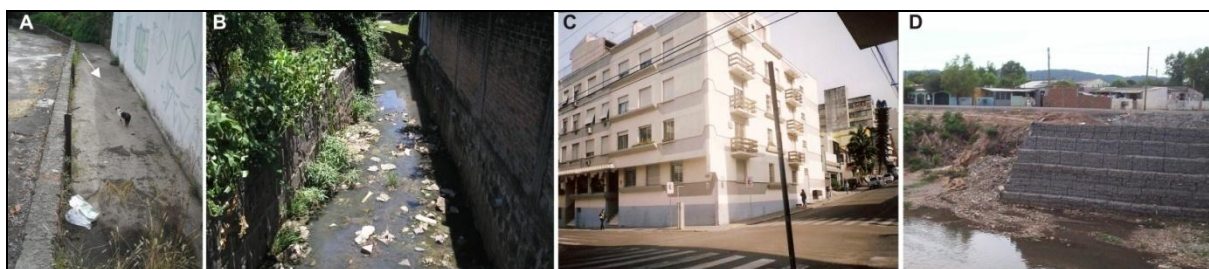
Figura 10 - Alguns tipos de intervenções na rede hídrica da área urbana de Santa Maria. A) Canalização em galeria de concreto fechada (indicação seta), Arroio Sanga da Aldeia; B) Canalização aberta – Arroio Sanga do Hospital; C) Impermeabilização da nascente do Arroio Sanga da Aldeia, no centro de Santa Maria; D) Detalhe da recomposição na margem do Arroio Cadena, com a colocação de gabião nas margens.
