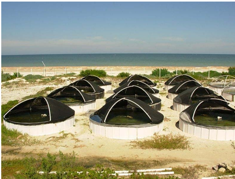
Figura 3 Área de Tanques Exteriores UMDI-UNAM
