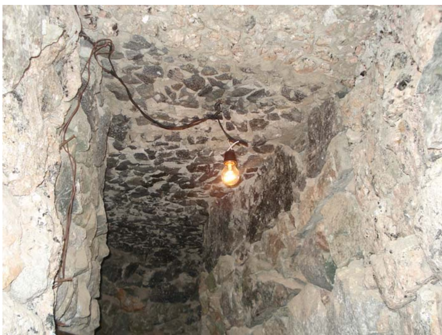
Figura 37. Fiação à mostra na Sala da Mina Brejuí, 2008. Foto nossa.
