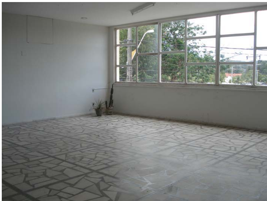
Figura 47. Hall do primeiro andar praticamente inutilizado, 2008. Foto nossa.
