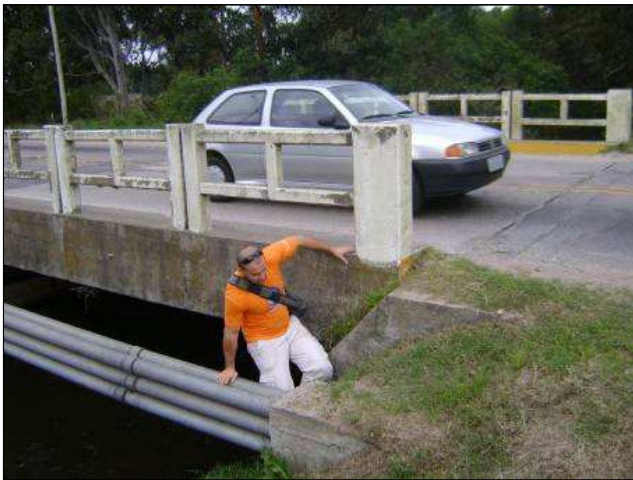
Ponte, junto a RS-734, sobre o arroio Vieira.
