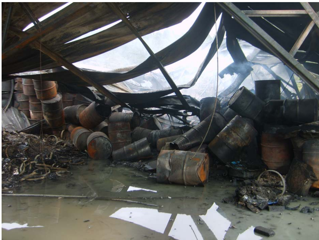
Fotografia 13: Água empoçada junto aos escombros, utilizada no combate ao incêndio do galpão de estocagem de resíduos tóxicos em cimenteira de Cantagalo, RJ. Foto de autor anônimo, em 27/08/2007.
