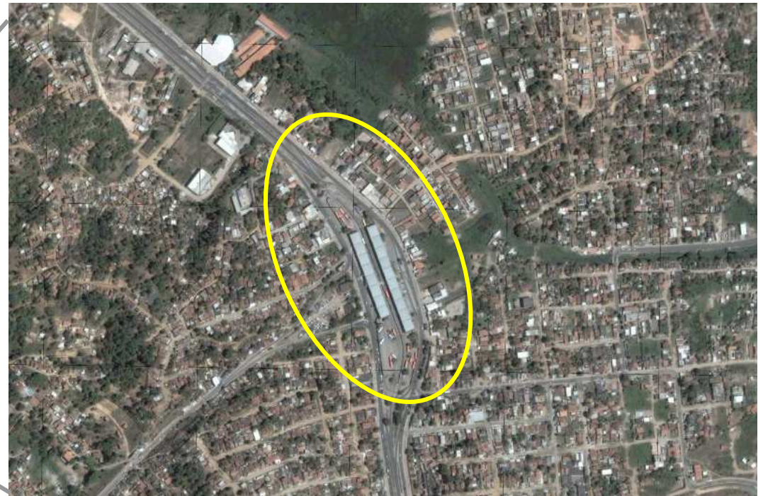
Terminal da PE-15
