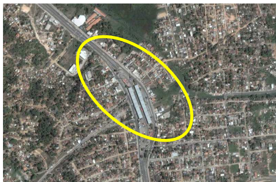
Terminal da PE-15
