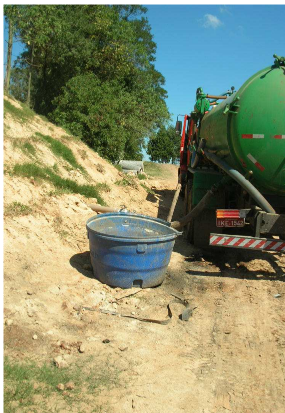
FOTO 25 – Talude do tanque de efluentes líquidos.
