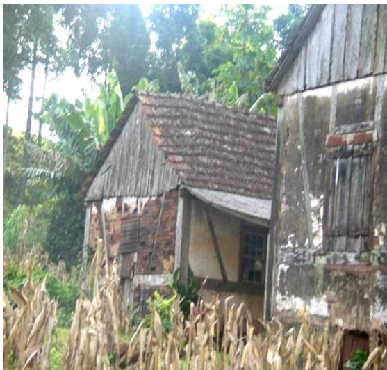
FOTO 3 – Casa estilo enxaimel em Linha Nova (RS) – edificação de 1860.
