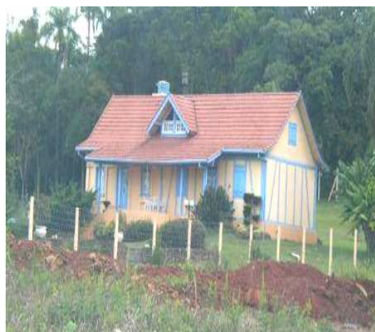
FOTO 6 – Casa em estilo enxaimel, em Linha Nova (RS), edificação do séc. XXI.
