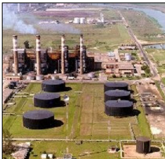
Figura 1 - Usina Termoeletrica de Santa Cruz
