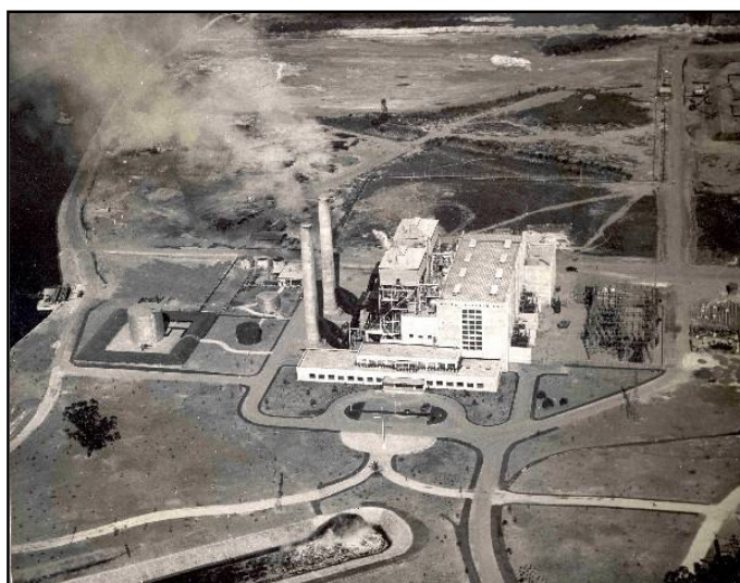
Figura 4 - Unidades geradoras 1 e 2 da Usina Termoeletrica Piratininga
