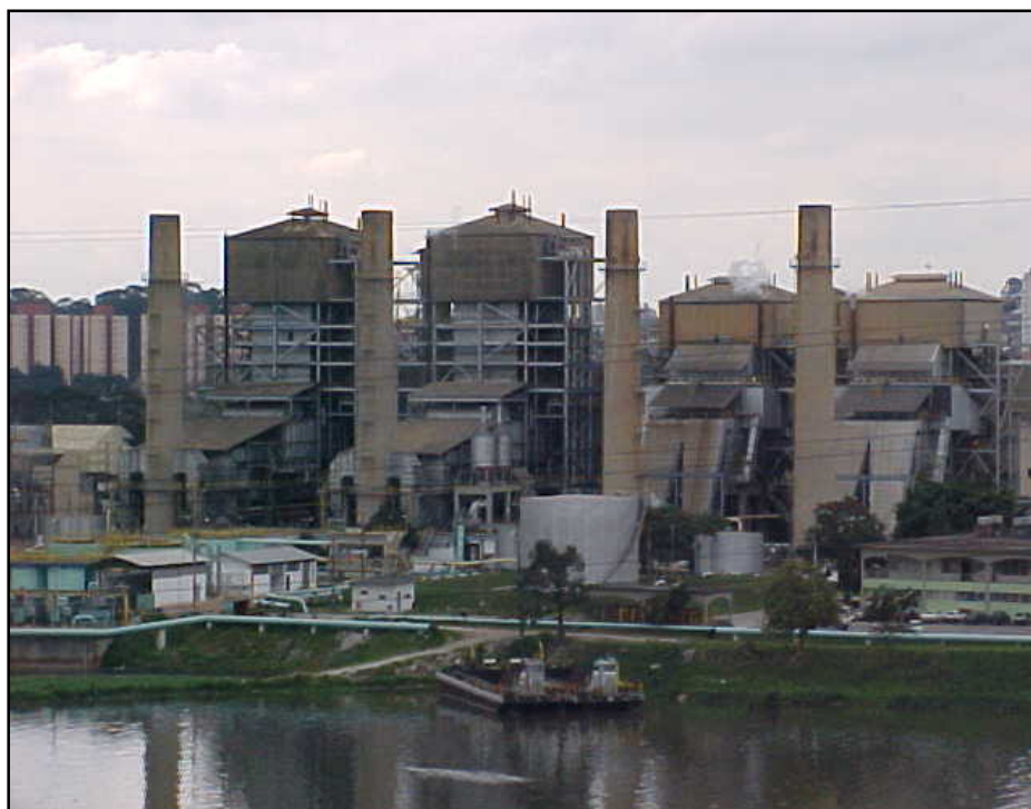
Figura 5 - Unidades geradoras 1 a 4 da Usina Termoelétrica Piratininga
