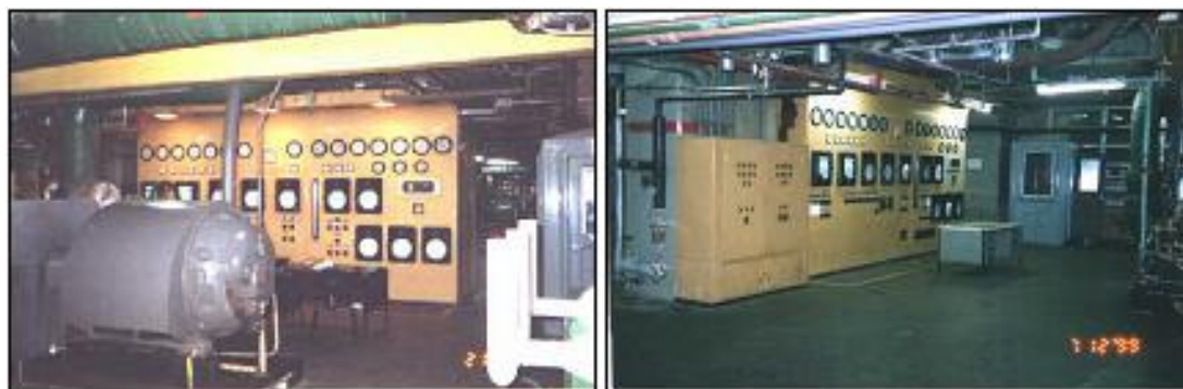
Figura 25 - Painel da alimentação e condensado
