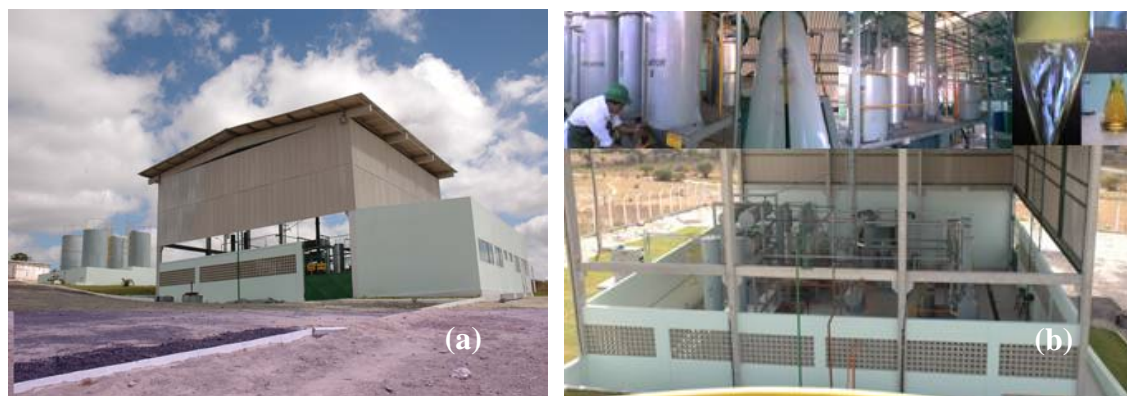
Figura 3.2.2 – (a) Unidade Piloto de Biodiesel de Caetés e (b) visão geral dos equipamentos para o processo de produção de biodiesel.
