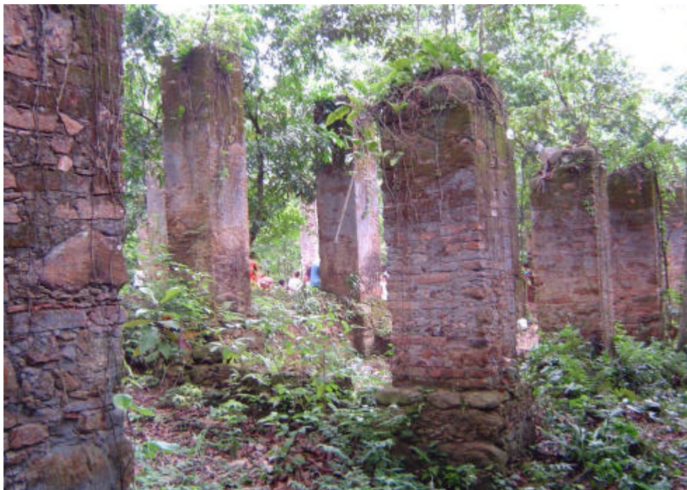
Figura 04 - Ruínas da antiga senzala do Comendador Breves, na Praia da Armação.
