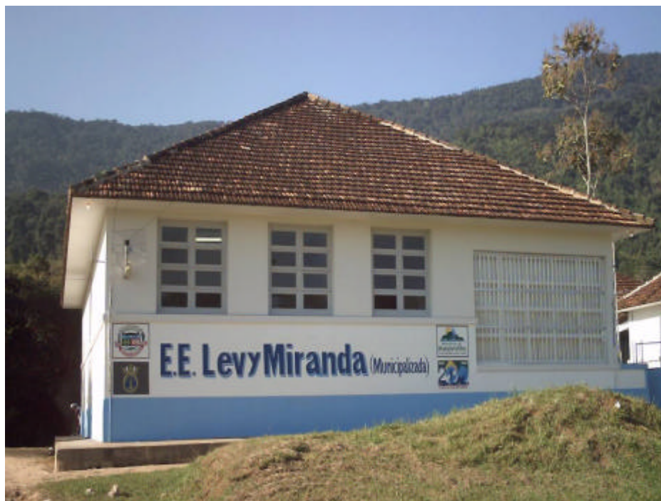
Figura 16 - Vista panorâmica da fachada da Escola Municipal Levy Miranda. Fonte: trabalho de campo, 2008.
