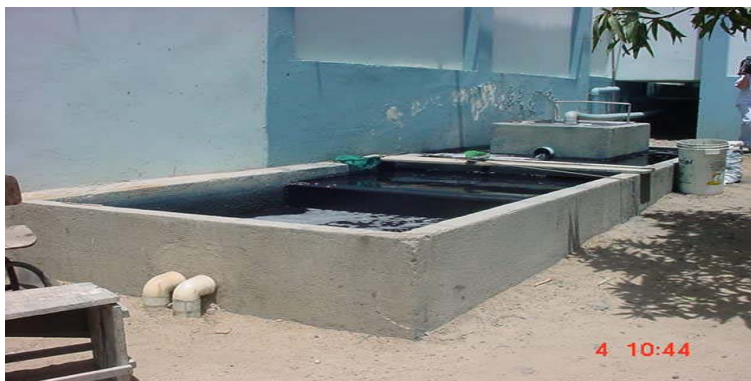
Figura 1 – Tanque de equalização de efluentes líquidos Lavanderia “Hamuche” Toritama - PE
