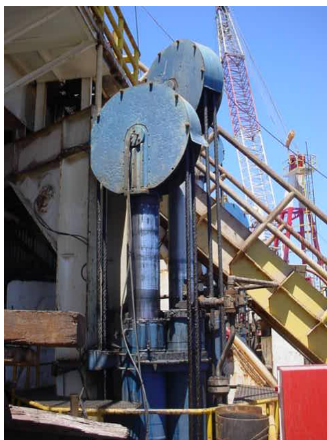
Figura 1.11 - Tensionadores tipo dual da plataforma SEDCO 710
