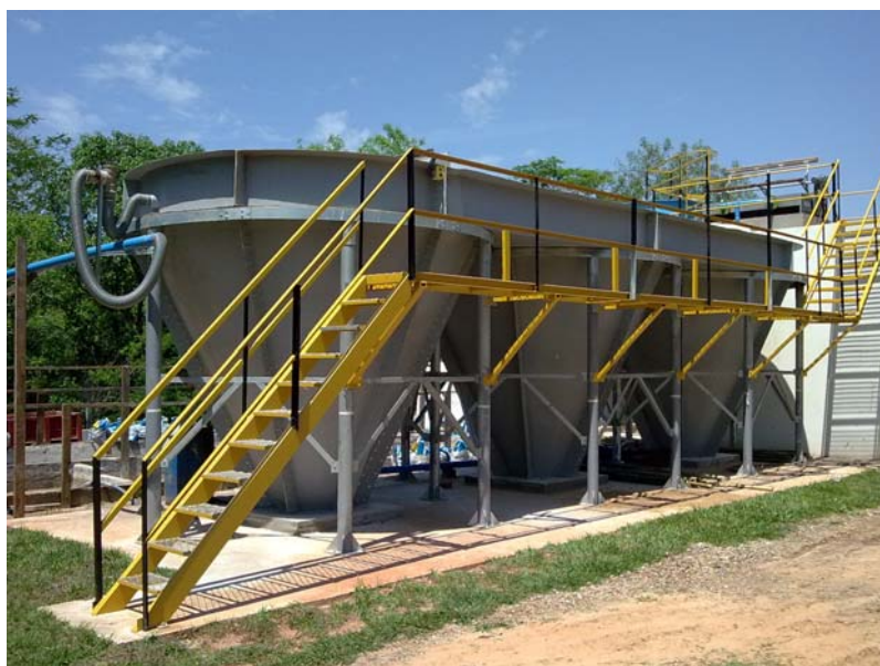
Fotografia 5 – Decantador em espiral para o tratamento de efluentes. Fonte: elaboração própria.
