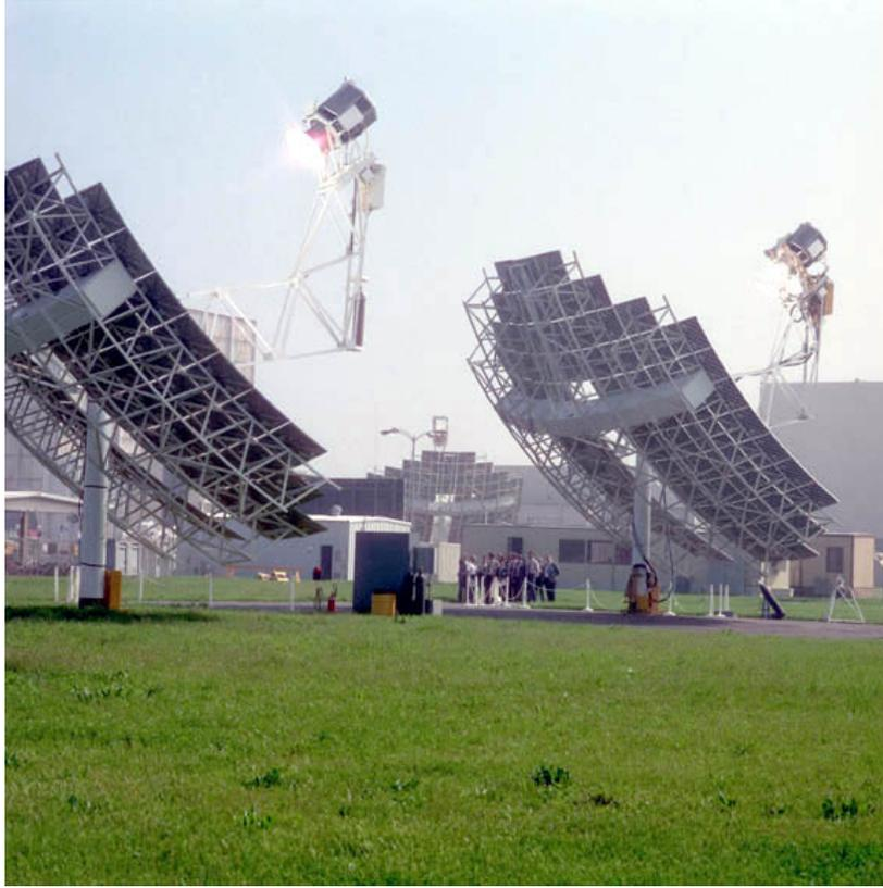
Fig. 9 – Conjuntos motogeradores e concentradores parabólicos Califórnia Edison,EUA (SANDIA, 2006)
