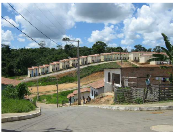
Foto 06 – Modelo dos conjuntos habitacionais próximos ao bairro de Valéria.
