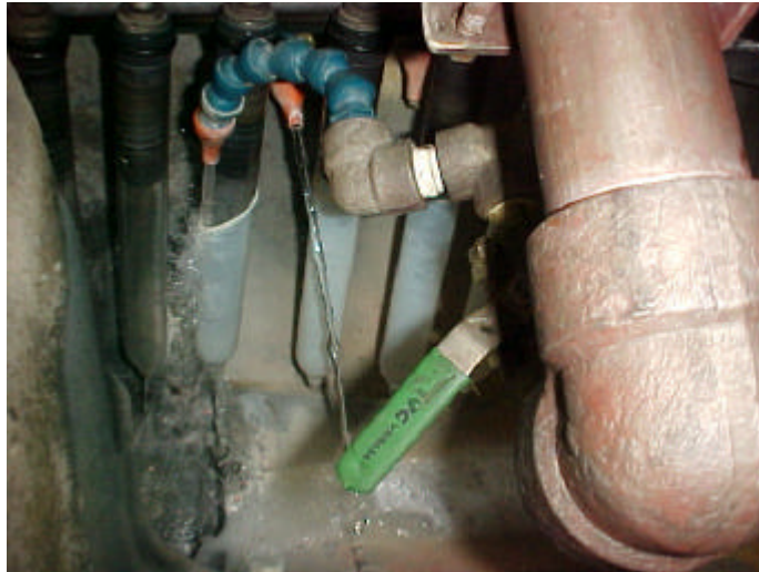
Figura 26 Retirada do preservativo do molde por jato de água
