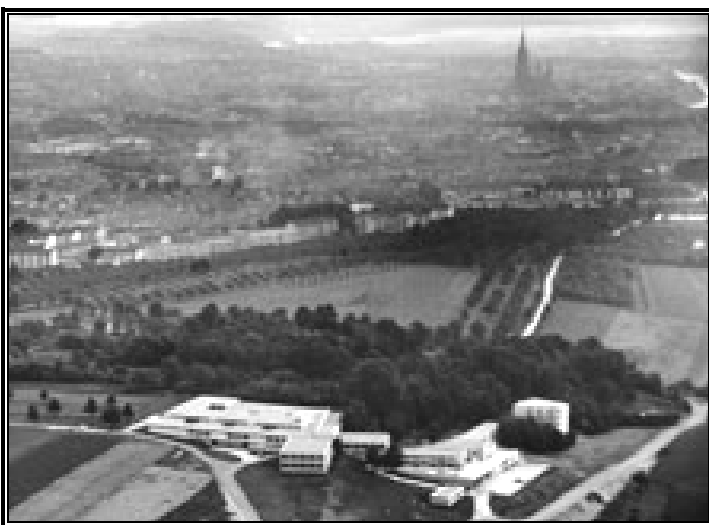
Figura 45 - Vista aérea da Escola de Ulm – Alemanha (1955) Fonte: www.parana-online.com.br
