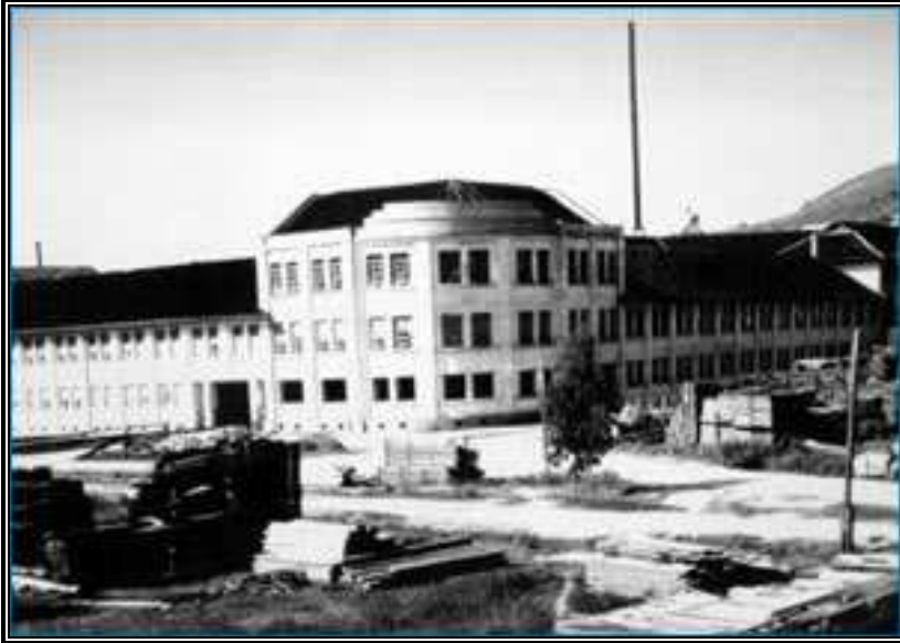
Figura 59 - Vista da empresa parcial da antiga Móveis Cimo Fonte: www.hhenkels.googlepages.com
