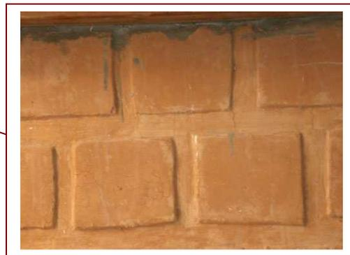
**Detalhe da parede externa com bloco de adobe**
