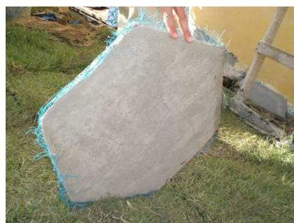
**Peça da estrutura geodésica do reservatório**
