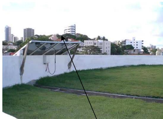
Placas fotovoltaicas orientadas para a fachada onde incide maior quantidade de raios solares.
