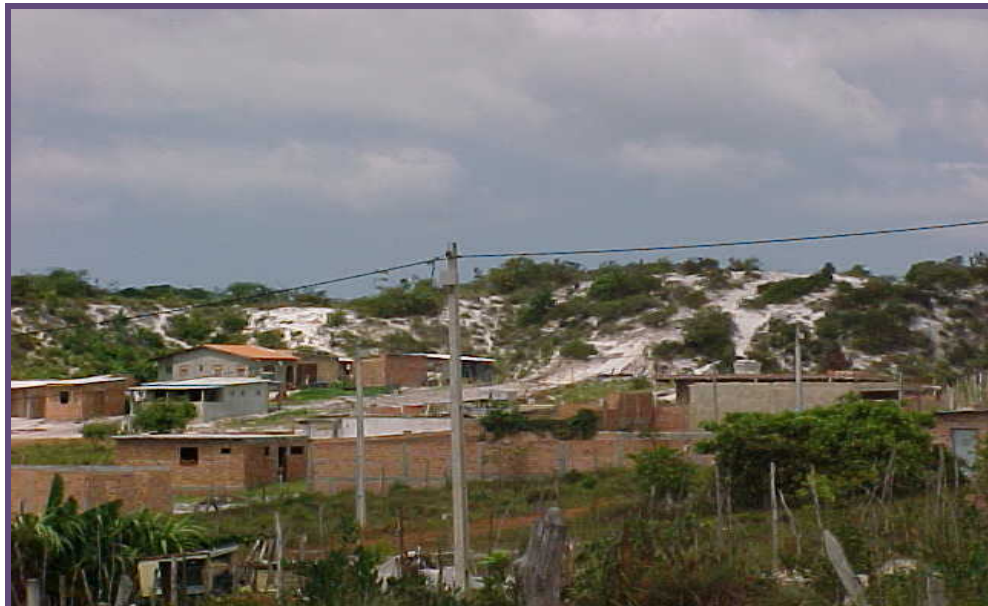
02 – Ocupação desordenada em área de preservação permanente – Vila de Abrantes - Camaçari
