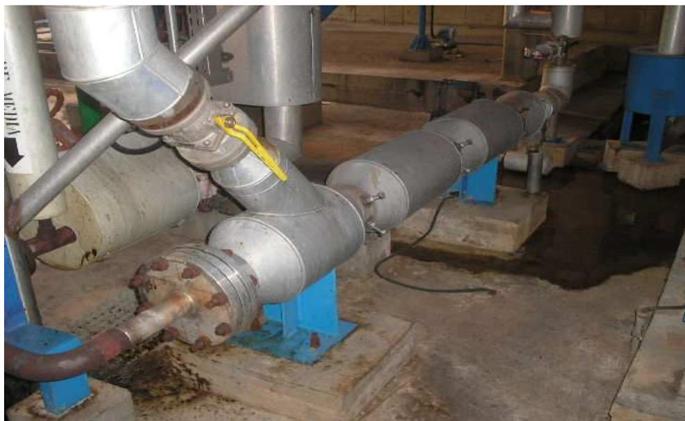
Figura 13 – Aquecedor de licor preto do tipo direto da caldeira de recuperação química B
