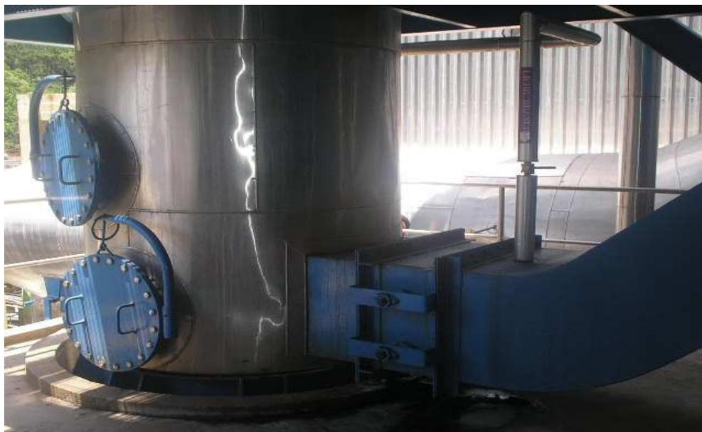
Figura 19 – Lavador de gases da caldeira de recuperação química B
