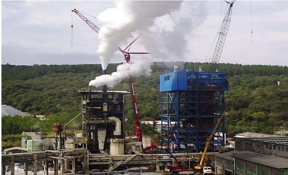
Figura 5 – Construção da caldeira de recuperação química B (nova)
