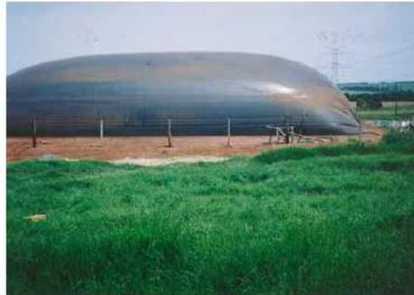
Figura 4: Biodigestor modelo canadense
