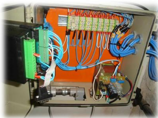
Figura 4.1.9-1 – Fiação e instalação do CLP
