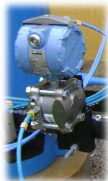
Figura 4.1.6-1 – Sensor medidor de pressão
