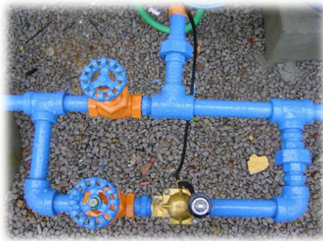
Figura 4.1.4-1 – Válvulas manuais de controle de gás e válvula solenóide
