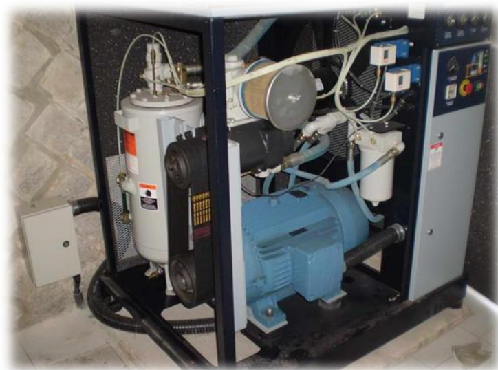
Figura 4.1.1-3 – Compressor internamente
