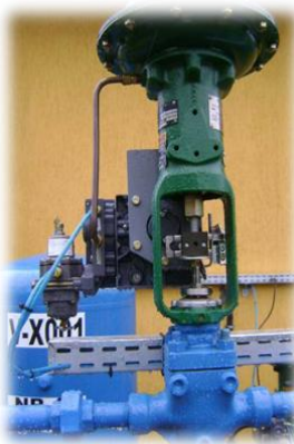
Figura 4.1.6-2 – Válvula de controle de pressão
