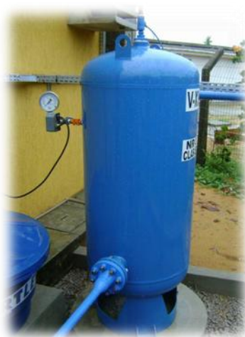
Figura 4.1.5-1 – Vaso de pressão separador bifásico
