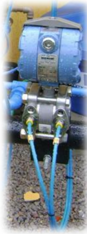
Figura 4.1.5-3 – Sensor medidor de nível por pressão diferencial
