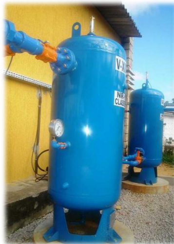
Figura 4.1.3-1 – Vaso pulmão do sistema
