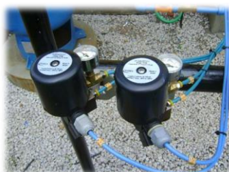
Figura 4.1.8-2 – Conversores IP
