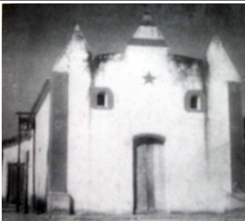
Figura 2.8. Igreja de N. Sr.ª d'Abadia em Formoso antes da reforma. Fonte: Mendes (2002).
