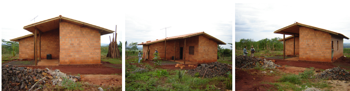
Figura 24: Imagens da casa de bloco cerâmico estrutural. Fonte: Grupo HABIS, 2008.
