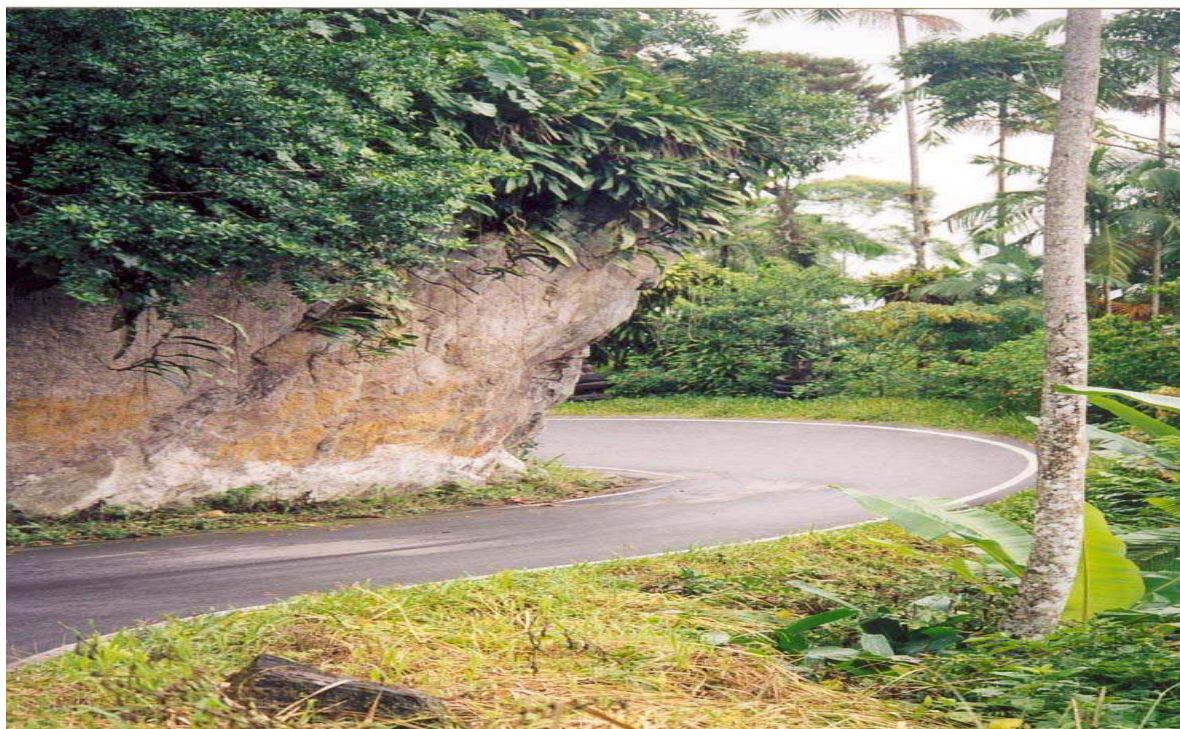
Fig.14 Trecho pavimentado da Estrada Paraty-Cunha, localizado dentro do Rio de Janeiro, fora dos limites do Parque Nacional da Serra da Bocaina.
