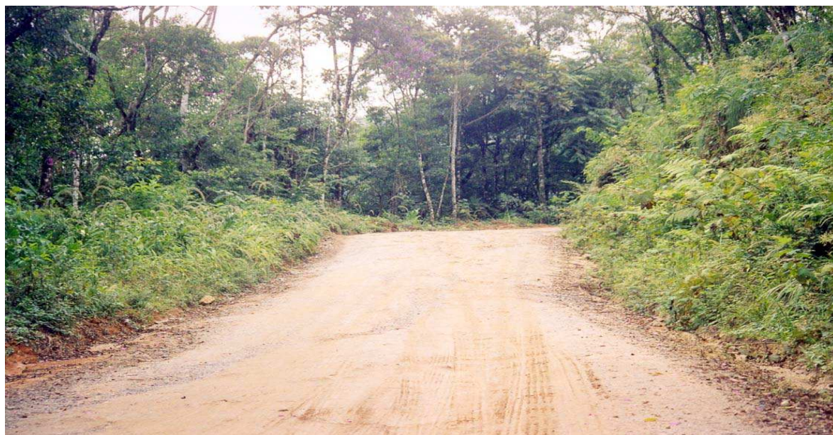
Fig. 15 Trecho da Estrada Paraty-Cunha, localizado no Estado do Rio de Janeiro, dentro do Parque Nacional da Serra da Bocaina.
