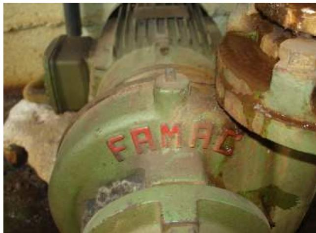
Figura III.16: Bomba FAMAC, responsável pelo retorno d'água.
