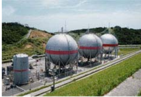
Figura 20. Central de armazenamento de hidrogênio líquido
