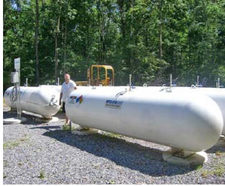
Figura 87: Tanques de hidrogênio.
