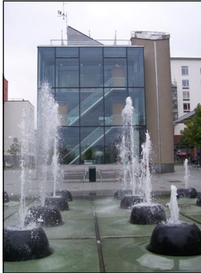
Figura 57: Edifício GlashusEtt , fachada principal
