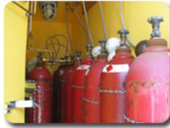
Figura 90: Tanques de hidrogênio
