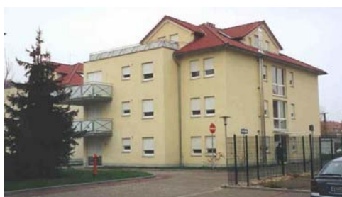
Figura 45: Edifício onde foi instalada a célula
