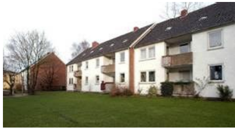
Figura 46: Edifício onde foi instalada a célula
