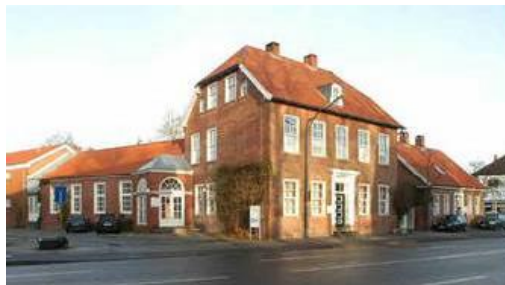
Figura 43: Edifício onde foi instalada a célula.
