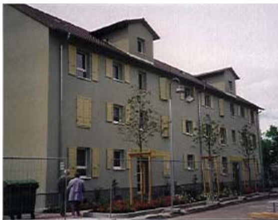
Figura 39. O edifício que foi chamado de " House of the Future, Prototype 1 ".
