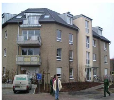
Figura 44: Edifício onde foi instalada a célula.
