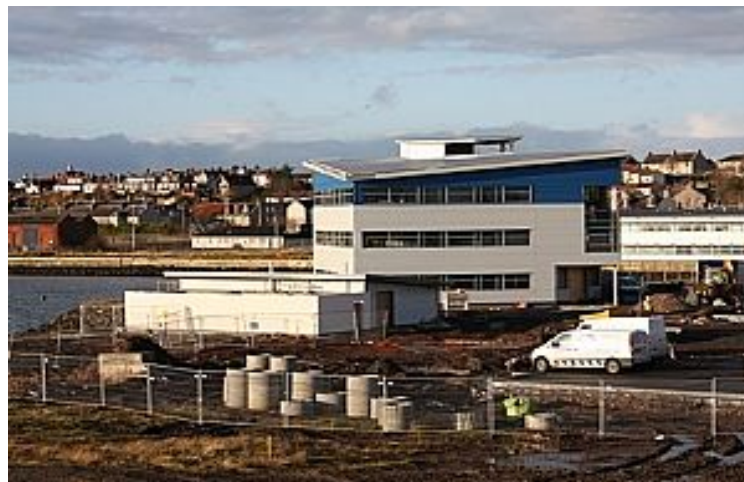
Figura 74: Edifício do Hydrogen Office
