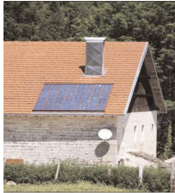
Figura 65: Painéis solares no teto da residência
