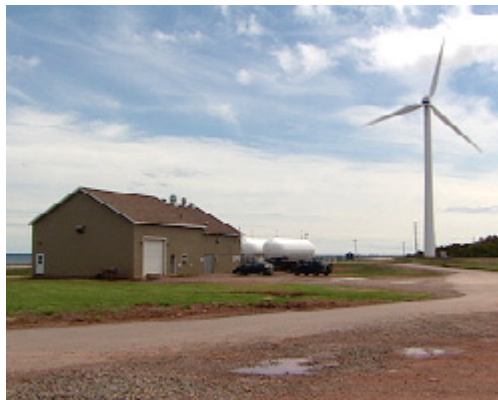
Figura 80: Casa de máquinas, turbina eólica e tanques de hidrogênio na PEI.
