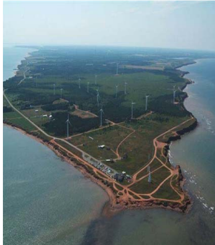
Figura 79: Turbinas eólicas existentes na PEI
