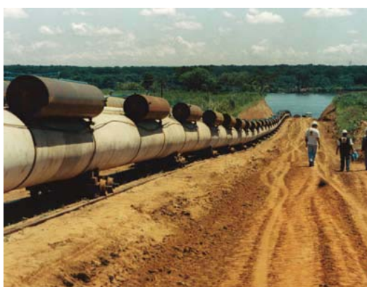
Figura 14. Construção do gasoduto Brasil - Bolívia
