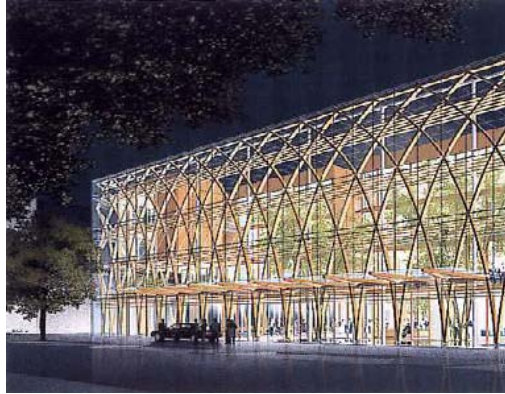
Figura 42: Fachada do Gabinete do Representante do Estado da Renânia do Norte-Vestefália
