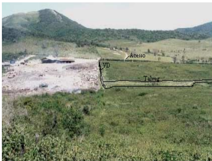
Figura 3.3. – Localização do lixão, vala de drenagem (VD) e talveg
