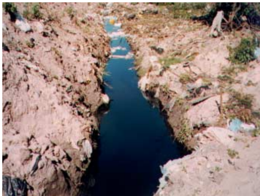
Figura 3.5. - Vala de drenagem (VD) a jusante do lixão.
