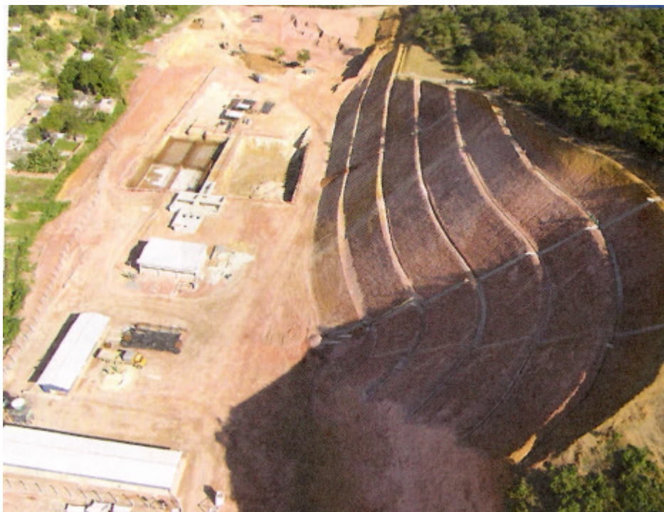
Figura 3.19 - Estação de Tratamento de Esgoto de Heliópolis
