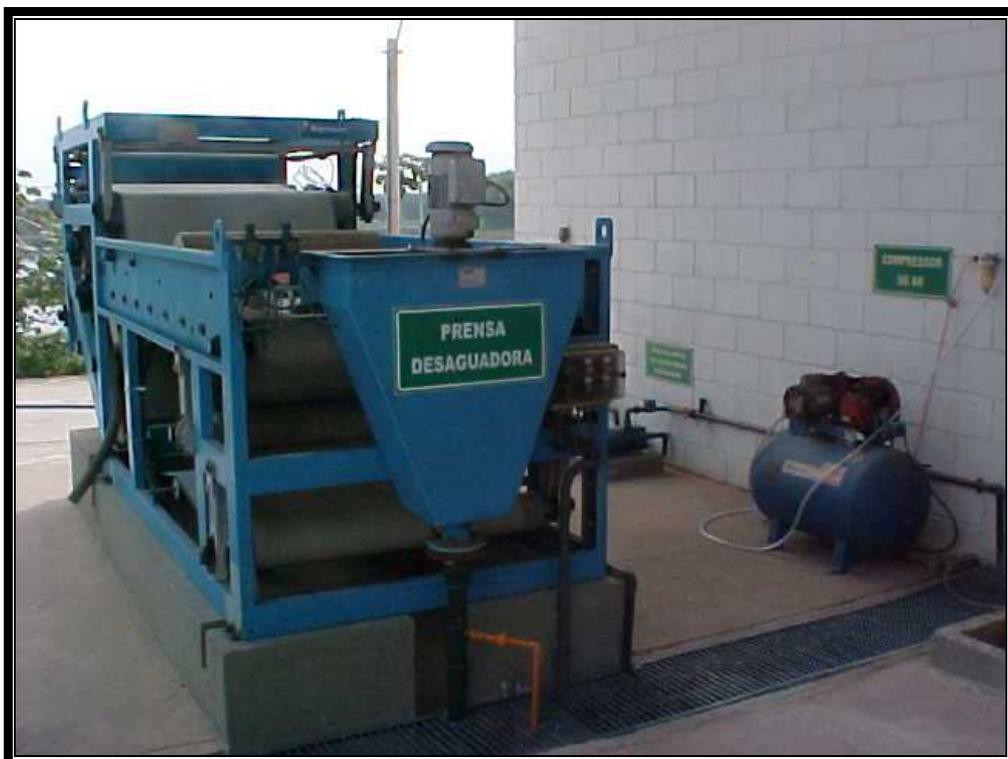
Foto 22 Prensa desaguadora do lodo.
