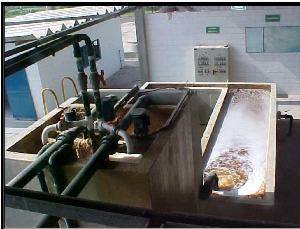
Foto 7 Misturador da solução de cal com chorume.
