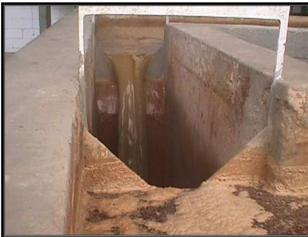
foto 9 Calhas de pré-sedimentação com medidor de vazão.
