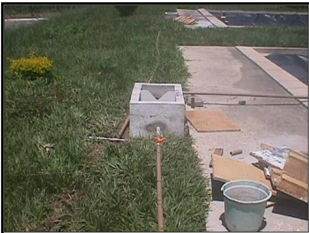
Foto 27 Caixa medidora de vazão.
