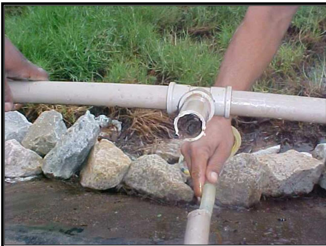
Foto 39 Tubulação entupida por material depositado
