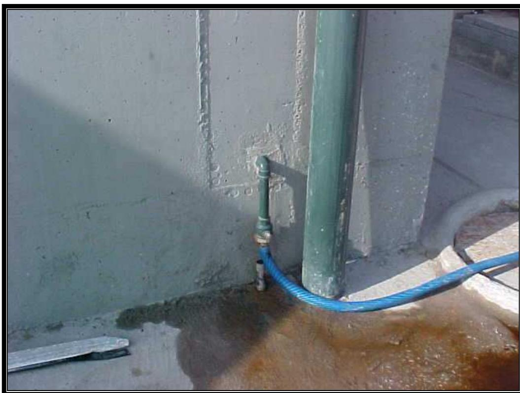
Foto 38 Substituição da tubulação de PVC.
