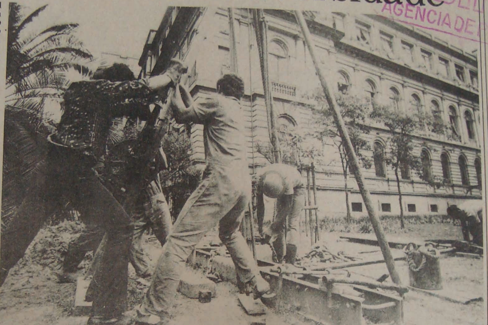
PREPARANDO A OBRA. Homens da Companhia do Metrô testavam ontem o solo da Praça da República perto da escola "Caetano de Campos" (ao fundo), para preparar o projeto de engenharia da futura estação da linha Leste-Oeste que ficará no primeiro andar daquele prédio.
