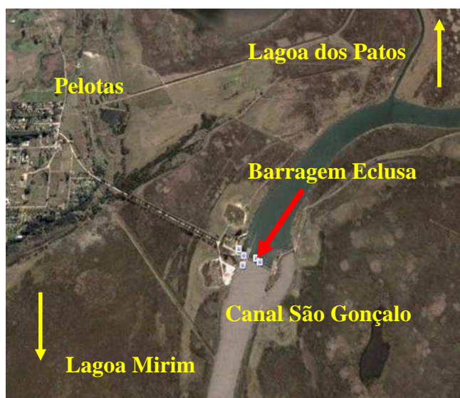
Figura 31 - Barragem Eclusa do Canal São Gonçalo, Pelotas, RS.
