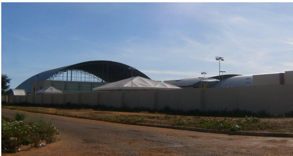
Figura 22 – Escola de Tempo Integral Eurídice Ferreira de Mello – instalações físicas para a prática de esportes (AUP II).
