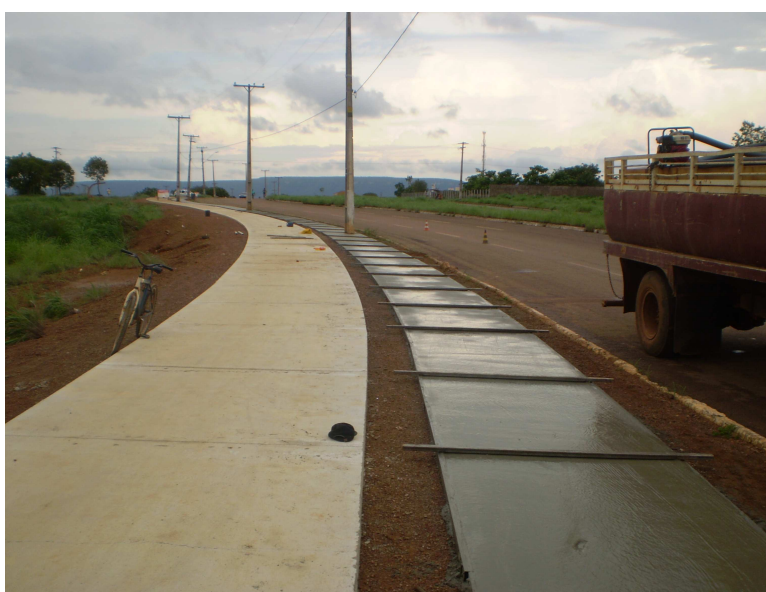
Figura 61: Ciclovía na Av. LO-12 na região norte. Fonte: ATTM – Assessoria de Planejamento.
