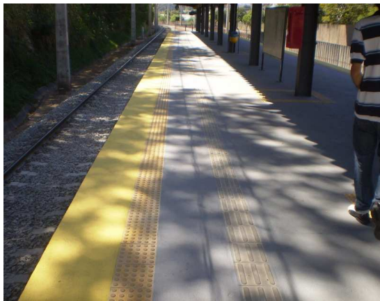
Figura 12: Piso podotátil – Passarela de pedestre. Fonte: www.skyscrapercity.com
