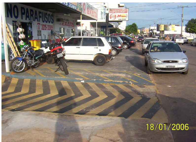
Figura 46: Veículos estacionados na calçada e entulho- 104 Sul. Fonte: ATTM – Assessoria de Planejamento
