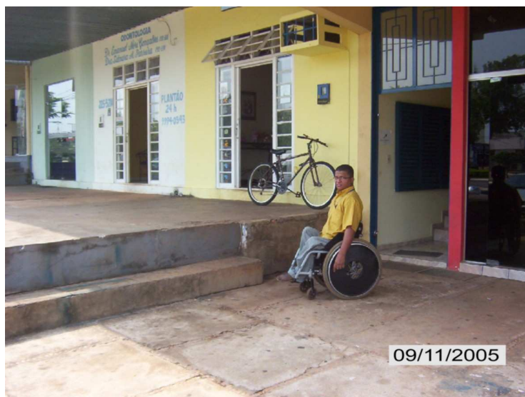
Figura 55: Desnível de passeios – Av. JK Palmas/TO. Fonte: ATTM – Assessoria de Planejamento.
