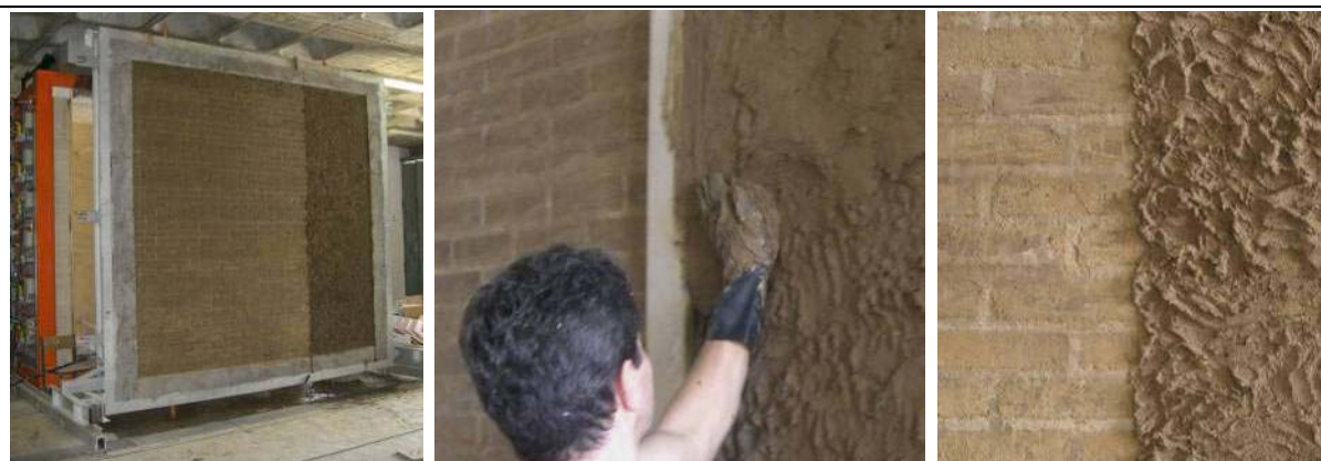
Fig. 27 – Execução de chapisco e reboco de solo-cimento em parede para ensaio de resistência ao fogo.
