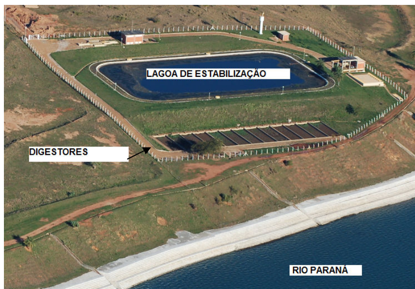
Figura 5. Estação de tratamento de Esgoto (ETE), em Presidente Epitácio, SP (2008).
