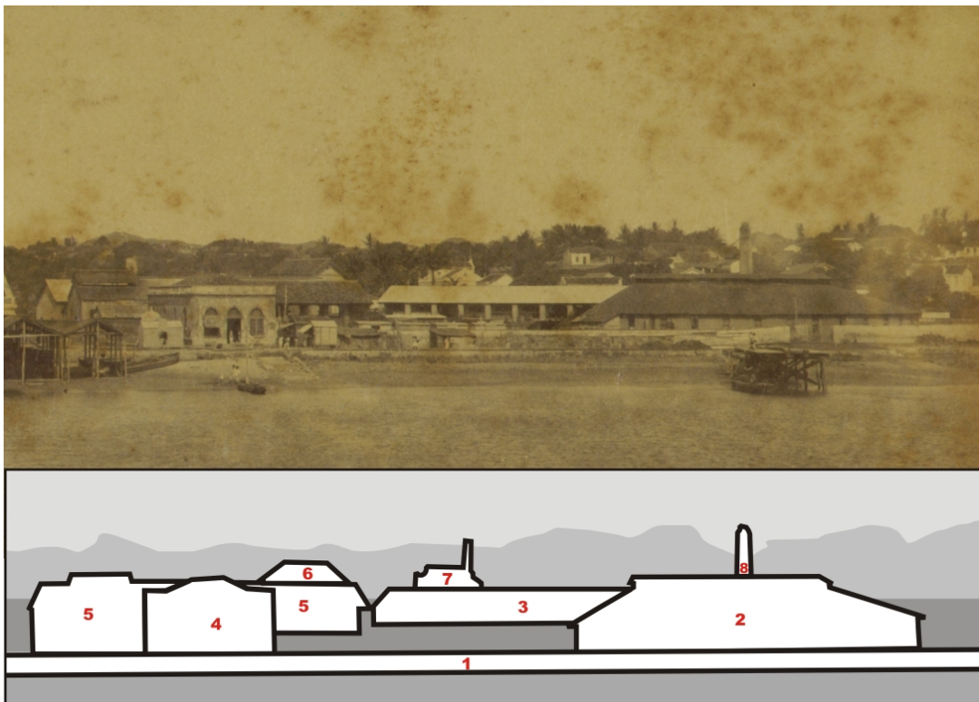
Fig. 34 – Vista do Parque ferroviário da Great Western a partir do rio Potengi, fotografia de Bruno Bougard, 1904. (Detalhe) Em primeiro plano o muro do “caes do salgado” (1) dividindo o rio do aterro. Podemos ver a rotunda e seu enorme telhado (2), os armazéns de vagões (3) as oficinas (5), ao fundo a torre da fábrica de tecidos da família Barreto (8) e mais a esquerda sua residência (7), ao lado o cumee da estação central da Great Western (6). A antiga escolinha da ribeira em breve desaparecería (4). Um cenário de modernidade começava a se formar por traz desses equipamentos. Fonte: Acervo do IHG/RN.
