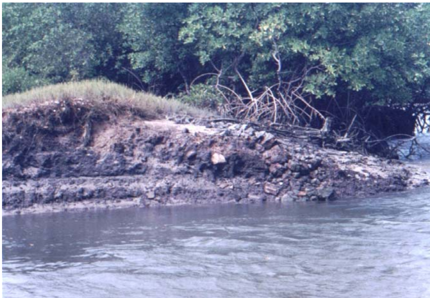
Fig. 14 – Trecho do aterro arrebetado, mostrando o perfil da estrutura. Há sobreposições de diferentes tipos de terra, sustentadas pelos muros de pedra. Foto: Leandro Renovato.
