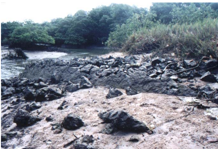
Fig. 13 – Taludes do Aterro. A inclinação da estrutura, para uma contenção mais eficiente da terra, é de cerca de 30 °. Foto: Leandro Renovato.
