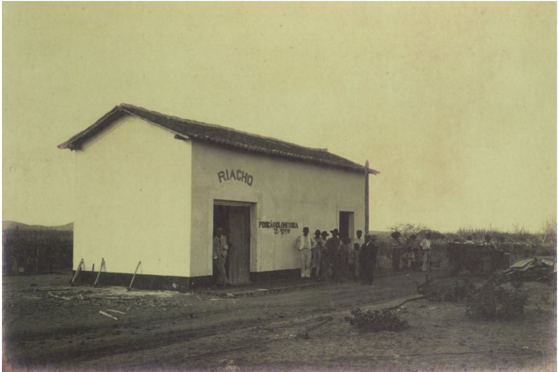
Fig. 67 – Estação do “Riacho” da Estrada de automóveis do Seridó (km. 72). Antecedendo as estações rodoviárias, esse prédio ainda toma como referência a clássica tipologia das construções ferroviárias. O prédio fica paralelo à via, com uma pequena calçada fazendo o papel da “plataforma de embarque”. Fonte: IHG/RN.
