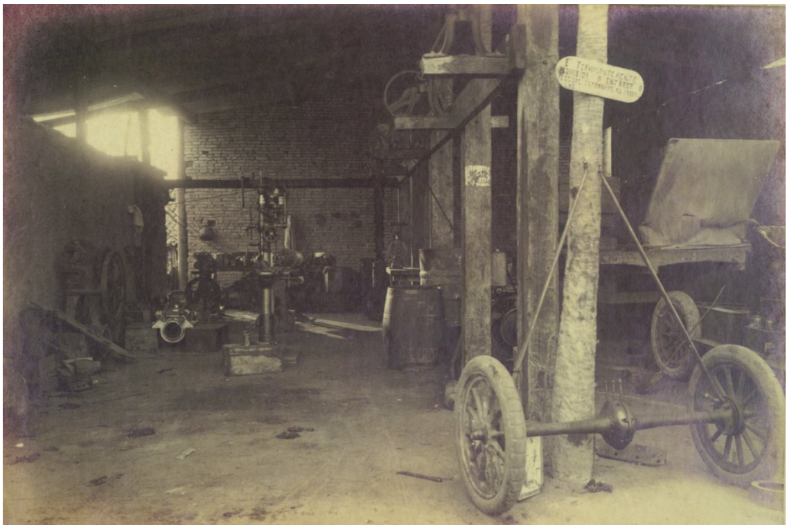
Fig. 68 – Oficinas de Reparos da Estrada de Automóveis do Seridó. Tomando como referência o aparato de oficinas que existiam nos parques ferroviários, a estrada de automóveis também terá esse espaço. A restrição da circulação aos serviços de manutenção do material rondante e a desvinculação do pátio da vida urbana também podem ser observados aqui. Assim diz a pequena placa na entrada das oficinas: “É terminantemente proibida a entrada de pessoas estranhas ao trabalho”. Fonte: IHG/RN
