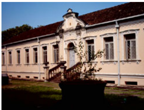
Prédio da Prelazia em Roraima, localizada no centro histórico da cidade de Boa Vista, construído no início do Século XX. Fonte: Portal do Governo de Roraima
