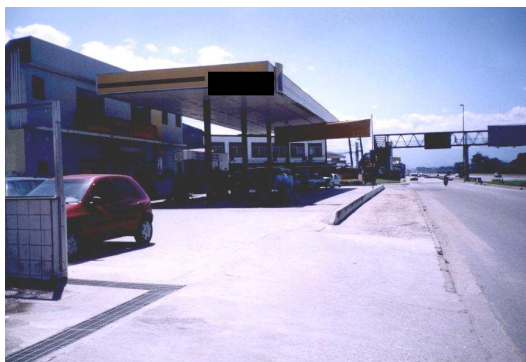
Figura 8.4– Aspecto geral do Posto 1, situado na Rodovia Washington Luís, sentido Rio.
