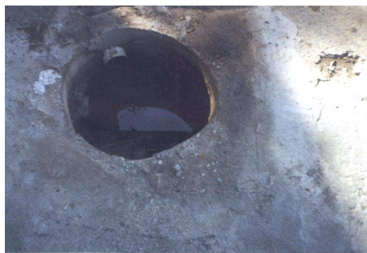
Figura 8.45 – Caixa de passagem onde foi coletado o efluente após o SAO.
