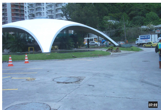
Figura 8.71– Aspecto geral do Posto 4.
