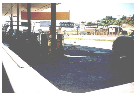
Figura 8.10 – Aspecto geral da área de abastecimento.
