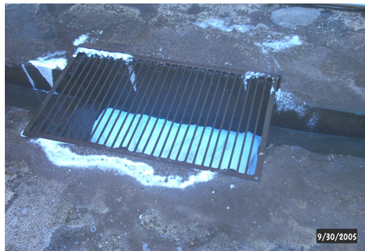
Figura 8.58 – Aspecto da caixa de areia com espuma. Este local foi um dos pontos de coleta do efluente bruto.
