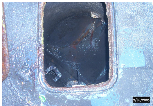
Figura 8.60 – Aspecto da caixa de passagem após o SAO 7 .
