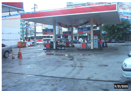
Figura 8.20 – Aspecto geral do Posto 3.
