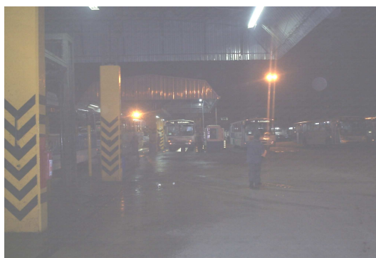
Figura 8.34 – Aspecto do pátio da Garagem de Ônibus.
