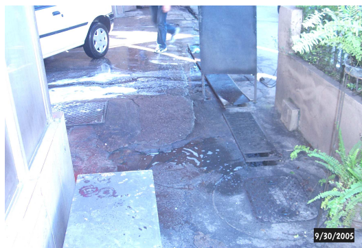
Figura 8.59 – Detalhe da calha com gradeamento e uma poça de água residuária contendo detergente fluindo para a caixa de passagem com dispositivo de visita fechado.
