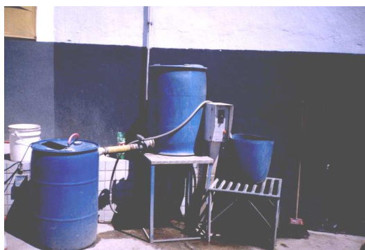
Figura 8.6 – Sistema de Jateamento de espuma com bombona de acumulação de detergente automotivo.
