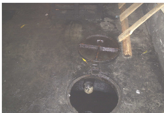
Figura 8.39 – Aspecto geral do SAO 4.
