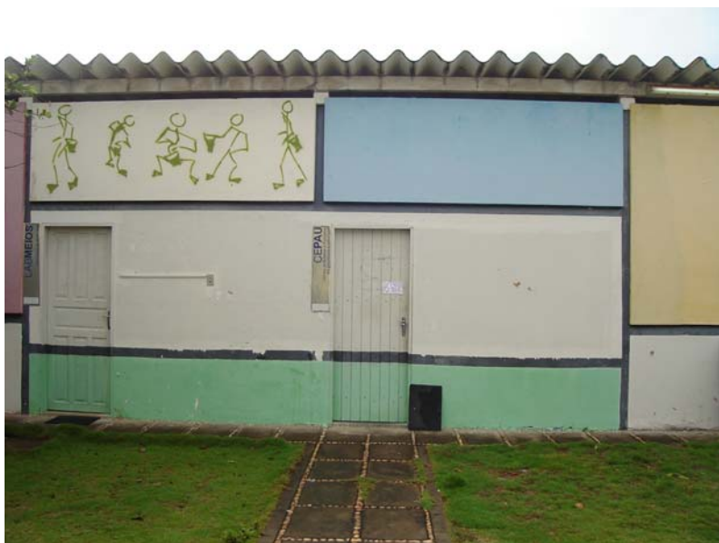
Figura 60 – Foto da parte externa da CEPAU antes da reestruturação
