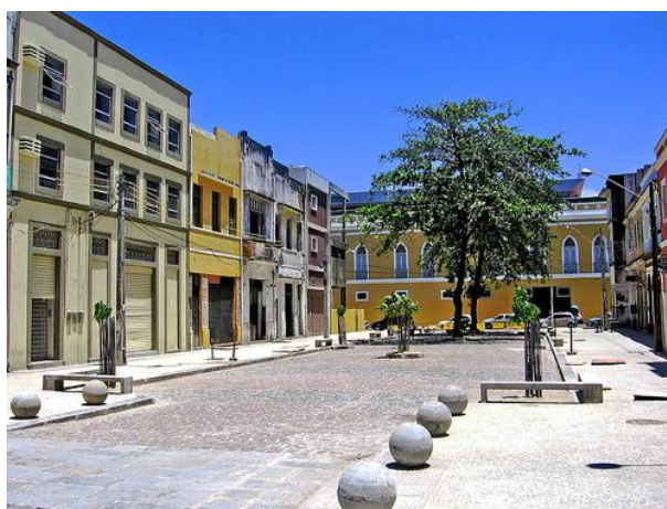
Figura 36: Rua da Moeda após obras de reabilitação do espaço urbano (Shopping Alfândega ao fundo).
