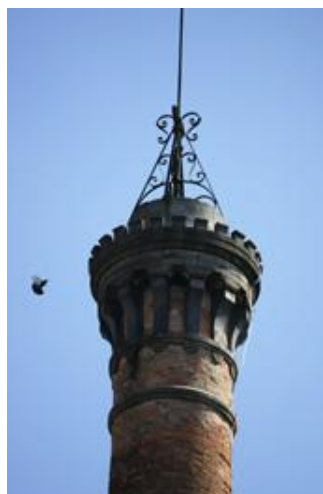
Figura 32: Detalhe da Chaminé restaurada. Fonte: http://www.monumenta.gov.br/site/?p=313
