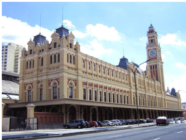
Figura 28: Estação da Luz. Fonte: http://commons.wikimedia.org/wiki/File:Esta%C3%A7%C3%A3o_da_Luz.jpg
