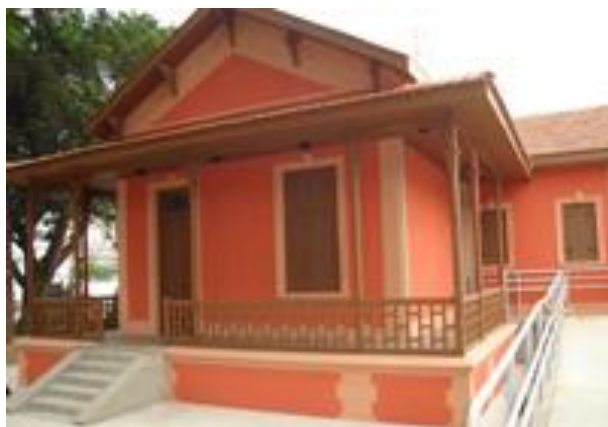
Figura 31: Casa do Administrador após as obras do Monumenta. Fonte: http://www.monumenta.gov.br/site/?p=313
