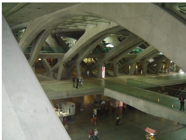
Figura 07: Interior da Estação do Oriente.
