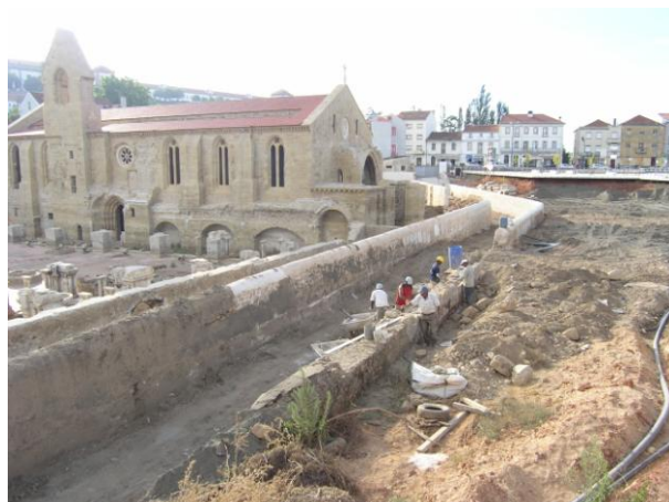
Figura 12: Obras do Polis no entorno do Mosteiro de Santa Clara-a-Velha. Fonte: Márcio Valença.
