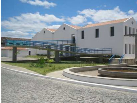
Figura 135. Rampa. Vista lateral. Fonte: Jober Pinto.
