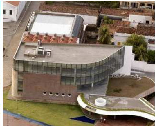
Figura 111. Fachada Sudeste. Curtain wall , pano revestido de cerâmica e canto marcado pela parede descascada da edificação preexistente. Fonte: Jober Pinto.
