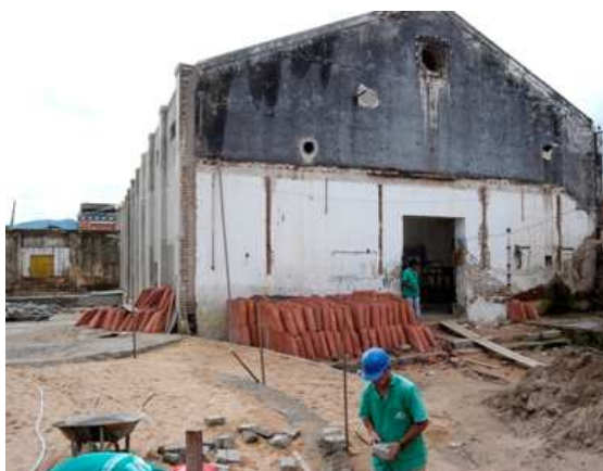
Figura 149. Galpão que abriga o teatro, antes da intervenção. Fonte: SEPLAM.
