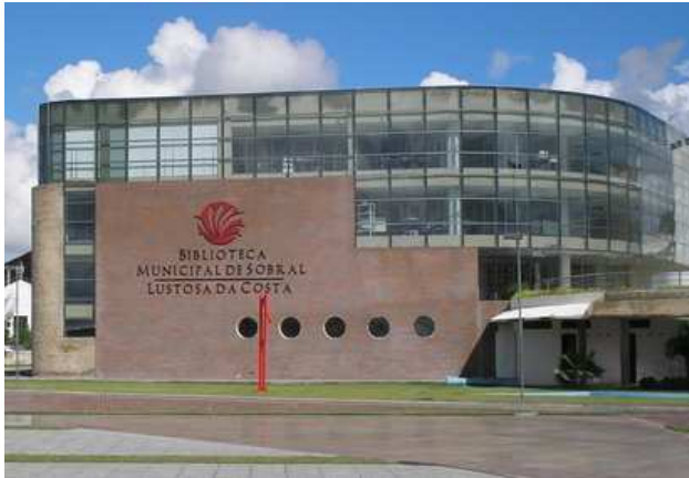
Figura 111. Fachada Sudeste. Curtain wall , pano revestido de cerâmica e canto marcado pela parede descascada da edificação preexistente. Fonte: Jober Pinto.
