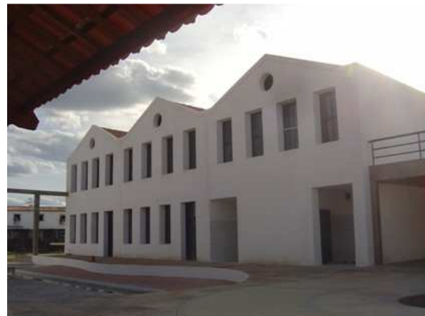
Figura 138. Galpões após a intervenção: parede vazada; beirais eliminados e um trecho deles substituído por marquise/circulação de concreto. Fonte: IBA.
