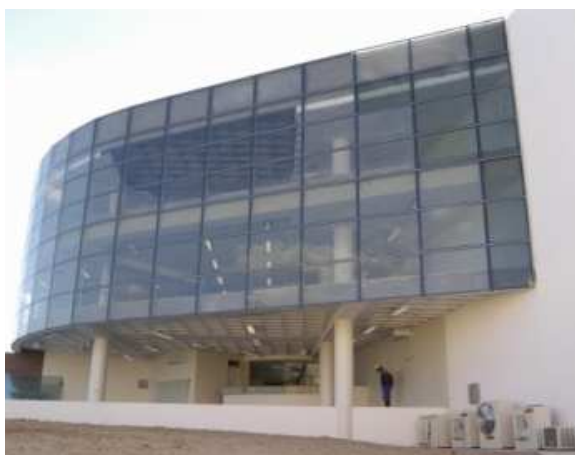
Figura 109. Fachada Nordeste. Sistema de estrutura independente com laje nervurada e vedação em curtain wall . Fonte: Arquivo da SEPLAM.
