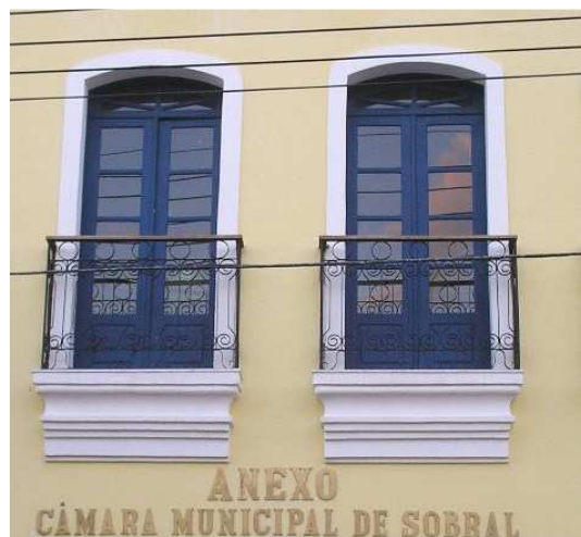
Figura 90. Detalhe do guarda-corpo metálico reproduzido. Fonte: Jober Pinto.
