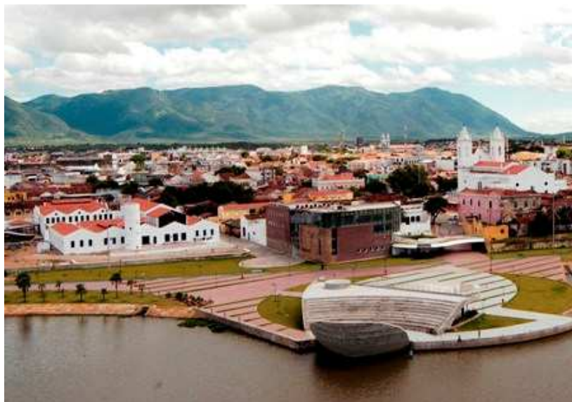
Figura 159. Vista aérea da estrutura que compõe o Museu avançando sobre o rio e sua relação com a Biblioteca, a ECCOA e, ao fundo, com a Igreja Matriz. Fonte: SEPLAM.
