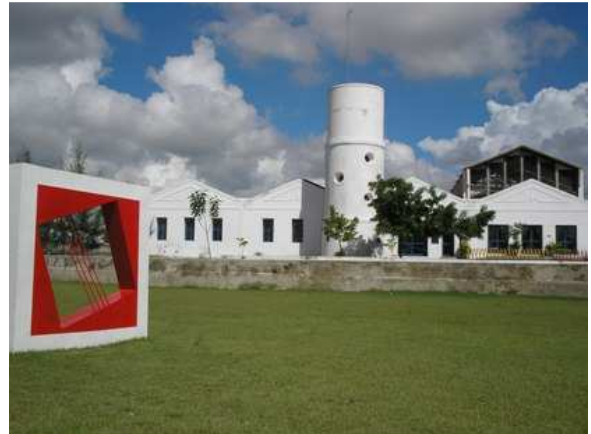
Figura 156. Edifício com a modificação concluída. Fonte: Jober Pinto.
