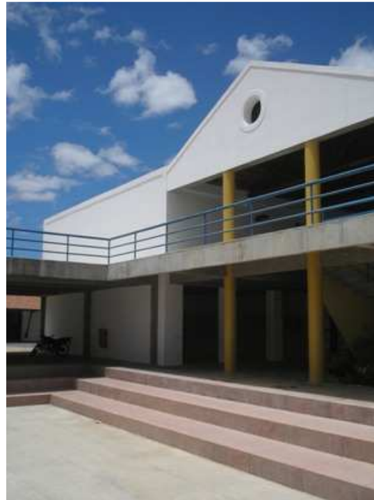
Figura 144. Parede do antigo galpão da figura 145 após a intervenção. Fonte: Jobert Pinto.
