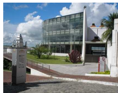
Figura 108. Fachada nordeste. Fonte: Jober Pinto.
