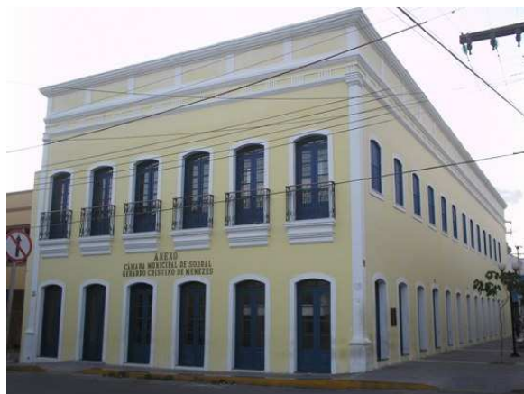
Figura 79. Fachadas reconstruídas e calçada. Fonte: Jober Pinto.
