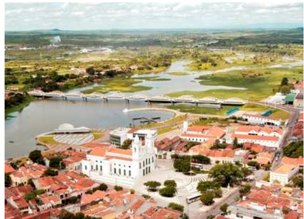
Figura 148. Vista aérea geral do entorno. Fonte: SEPLAM.
