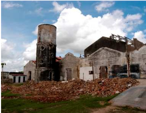
Figura 155. Estado da edificação após a derrubada do muro, durante as obras. Fonte: SEPLAM.
