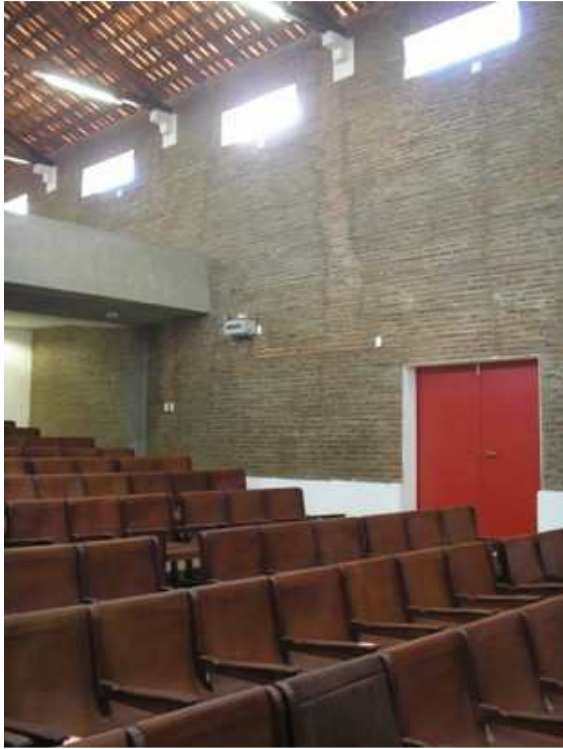
Figura 153. Parede lateral do teatro com estrutura original aparente. Fonte: Jober Pinto.
