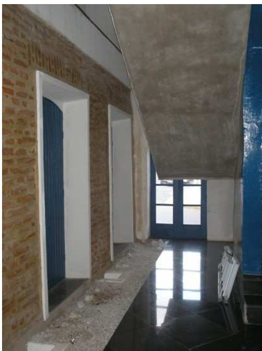
Figura 89. Parede pré-existente mantida no novo projeto. Fonte: Jober Pinto.
