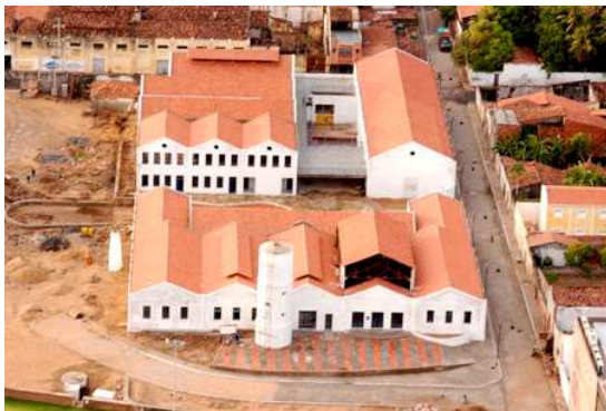
Figura 133. Implantação geral. Três conjuntos de galpões unidos por um pátio em "T". Fonte: SEPLAM.
