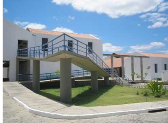
Figura 136. Rampa. Vista frontal. Fonte: Jober Pinto.
