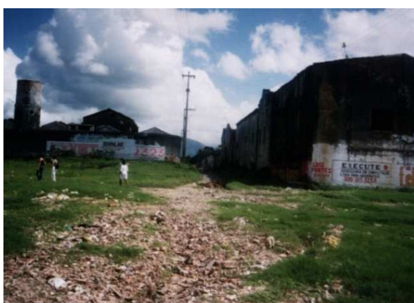
Figura 127. Vista a partir da margem do Rio antes da intervenção. À direita edificação demolida para construção da Biblioteca. Fonte: Acervo Ricardo Fernandes.
