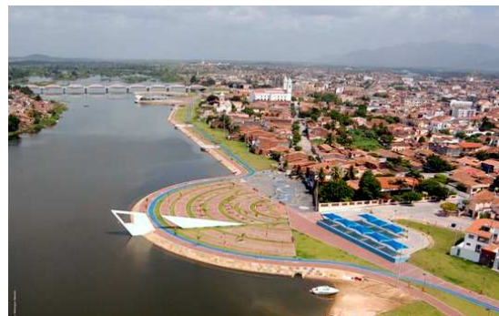
Figura 66. Vista aérea setor 4. Marco do tombamento. Fonte: SEPLAM.
