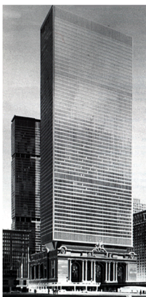
Figura 19. Adição proposta por Marcel Breuer para o Grand Central Terminal, em Nova York, 1968. Fonte: BYARD, 2005.
