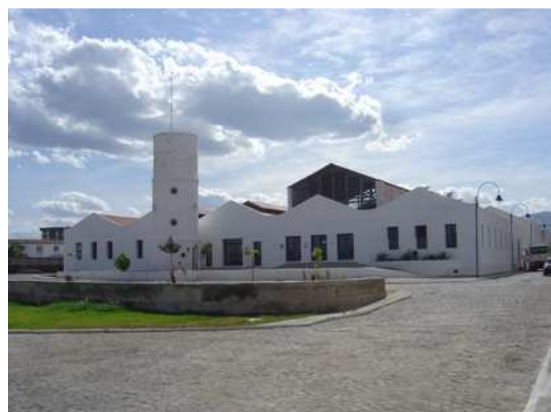
Figura 140. Edificação já sem o muro, aberta ao espaço público. Fonte: IBA
