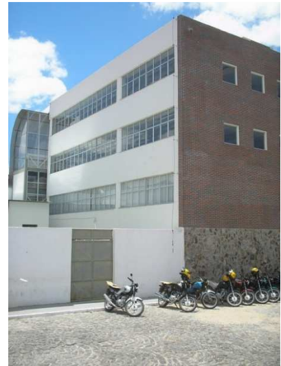
Figura 99. Fachada posterior com janelas faixa e, ao fundo, cobertura em policarbonato da rampa que une os quatro pavimentos. Fonte: Jober Pinto.
