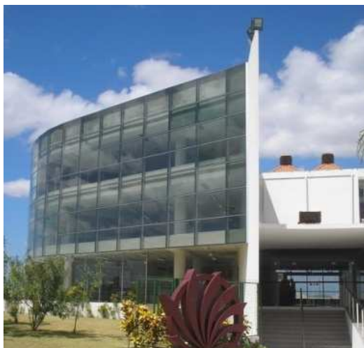
Figura 104. Fachada nordeste; empena e acesso principal. Fonte: Jober Pinto.
