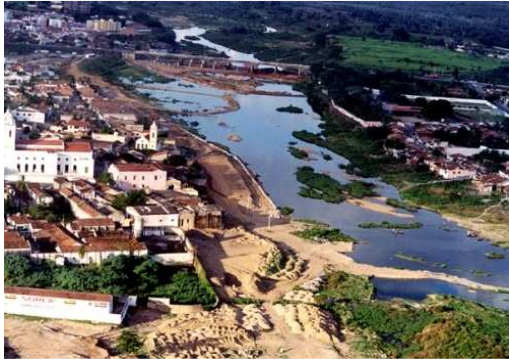
Figura 61. Margem esquerda durante as obras. Fonte: SEPLAM.
