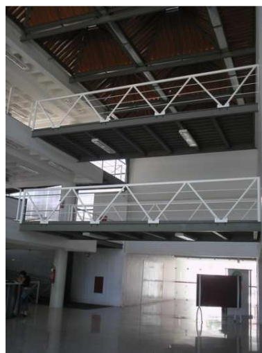
Figura 96. Vista do acesso principal a partir do átrio. Fonte: Jober Pinto.
