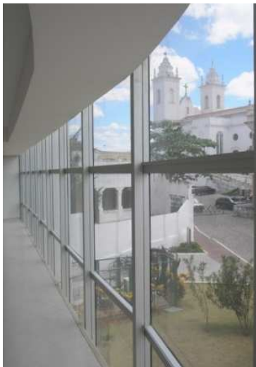
Figura 113. Detalhe interno da vedação em vidro. Fonte: Jober Pinto.
