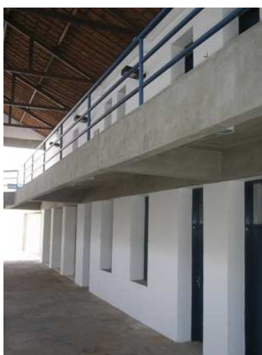
Figura 129. Espaço do galpão dividido em dois pavimentos. Fonte: Jober Pinto.
