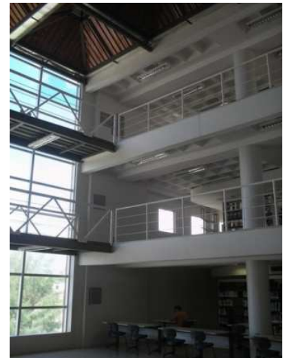
Figura 115. Interior. Pano de vidro; passarelas; coberta metálica com lanternim. Fonte: Jober Pinto.
