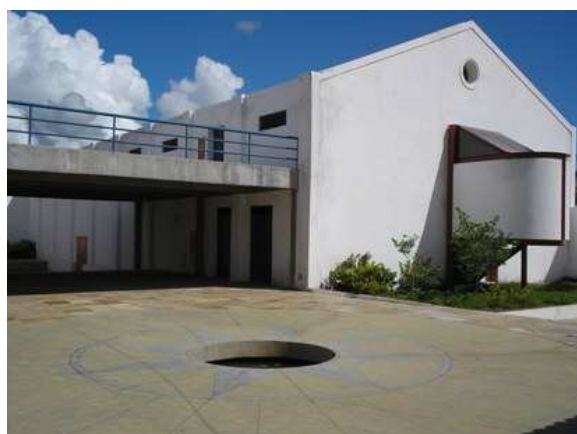
Figura 150. Bloco do teatro após a intervenção. O beledere une o teatro ao bloco vizinho criando uma área sombreada no pátio antes completamente aberto. Fonte: Jober Pinto.
