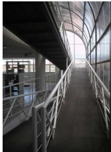
Figura 114. Rampa com cobertura em policarbonato. Fonte: Jober Pinto.
