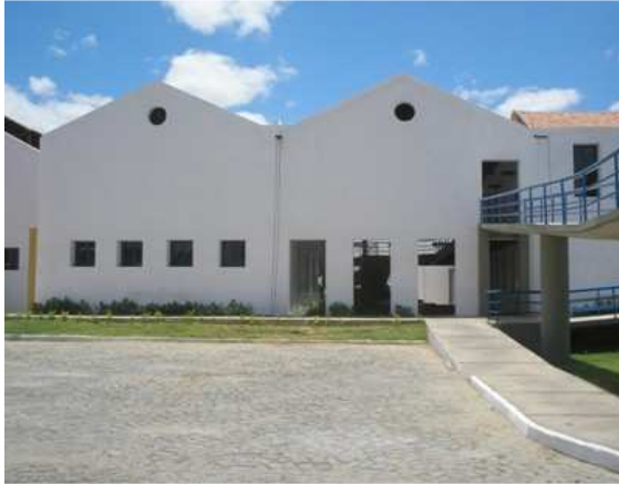
Figura 141. Parede externa de um dos galpões antes cega, e após a intervenção aberta ao exterior. Fonte: Jobert Pinto.
