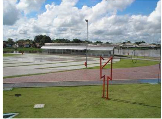
Figura 163. Vista desde o mirante da biblioteca. Fonte: Jober Pinto.
