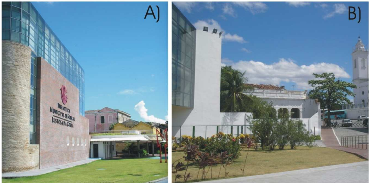
Figura 116. Relações cromáticas: (A) tijolinho cerâmico do pano de fachada/antiga fabrica Santa Emiliana ao fundo; (B) Empena /residência ao fundo. Fonte: Jober Pinto.
