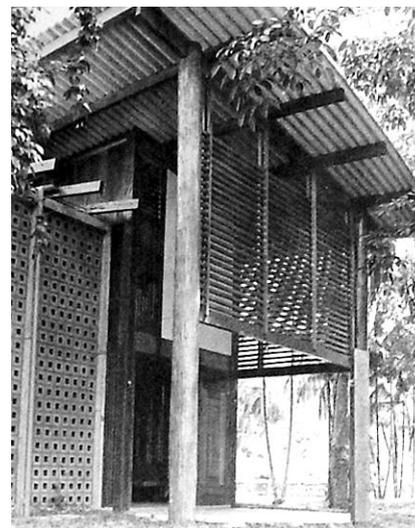
**FIGURA 25: Detalhe de uma fachada mostrando os grande beirais e o ripado de madeira no nível superior. Residência do Arquiteto. Arq. Severiano Porto.** (Fonte: Arquivo pessoal de Letícia Neves)
