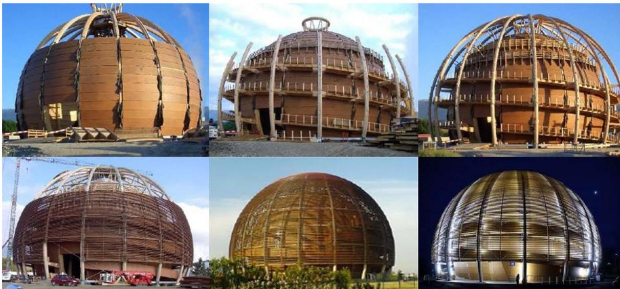
**FIGURA 5: The Globe of Science and Innovation, Suíça. Arq. Thomas Büchi e Hervé Dessimoz. Várias etapas do processo construtivo. Diâmetro da esfera 40m. (Fonte: [http://estruturasdemadeira.blogspot.com/2007\\_03\\_04\\_archive.html](http://estruturasdemadeira.blogspot.com/2007_03_04_archive.html))**
