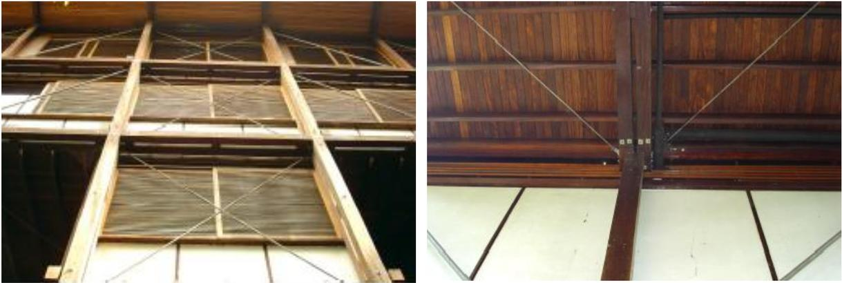
**FIGURA 63: Detalhes do contravento vertical e horizontal. Residência Hélio Olga, Arq. Marcos Acayaba.** (Fonte: Arquivo pessoal de NAKANISHI, 2007)
