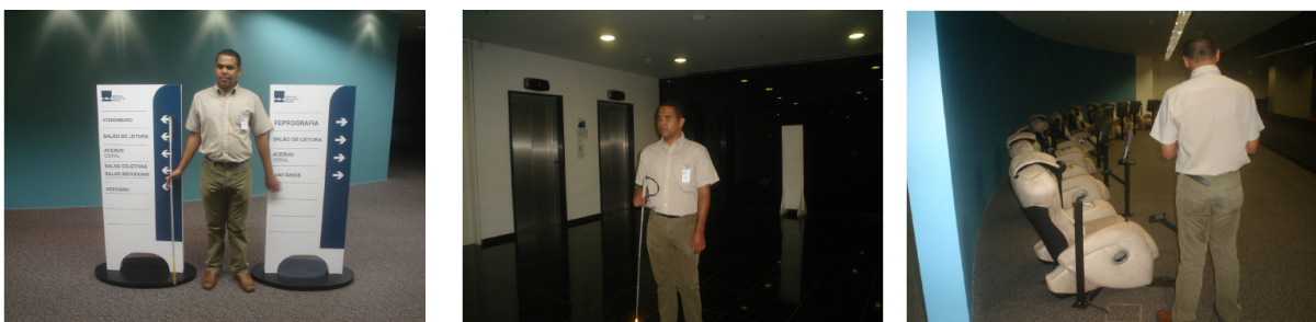
Ilustração 85 – Fotos das placas com sinalização visual não tem correspondência com nenhuma sinalização tátil, o hall dos elevadores não possui sinalização tátil no piso e cadeiras equipadas com aparelhos elétricos que não estão liberadas para uso, mas possui apenas uma sinalização visual informando tal restrição, passeio acompanhado com Gabriel na Biblioteca Nacional.
