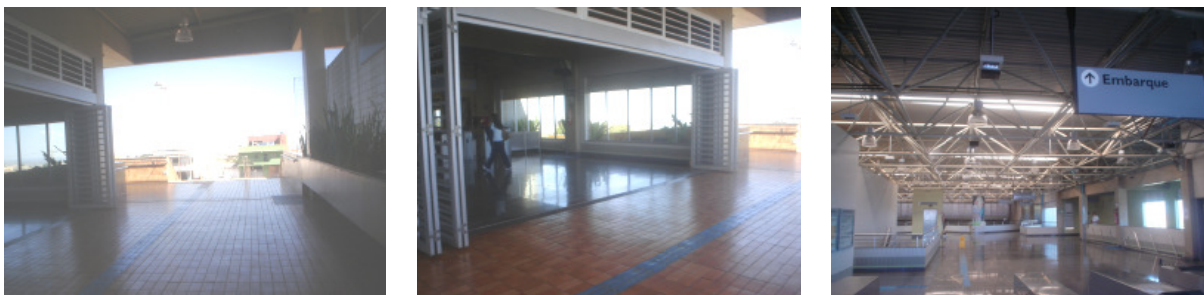
Ilustração 13 – Fotos dos acessos da Estação de Metrô Terminal Ceilândia.
