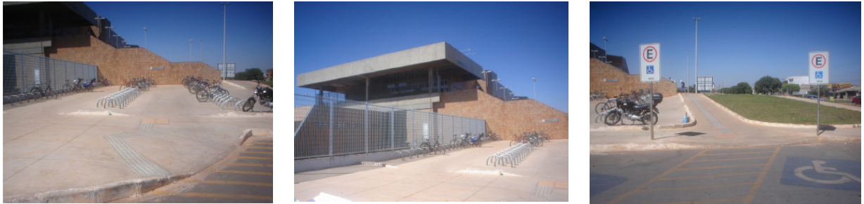
Ilustração 10 – Fotos do estacionamento da Estação de Metrô Terminal Ceilândia com piso tátil na calçada.
