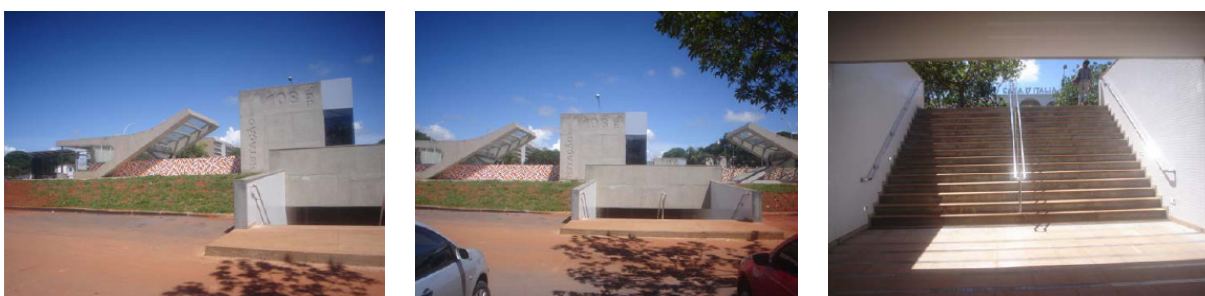
Ilustração 8 – Fotos do acesso e estacionamento da Estação de Metrô 108 Sul.
