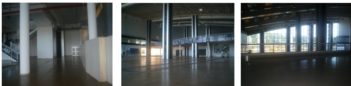
Ilustração 65 – Fotos da área de circulação interna do Centro de Convenções.
