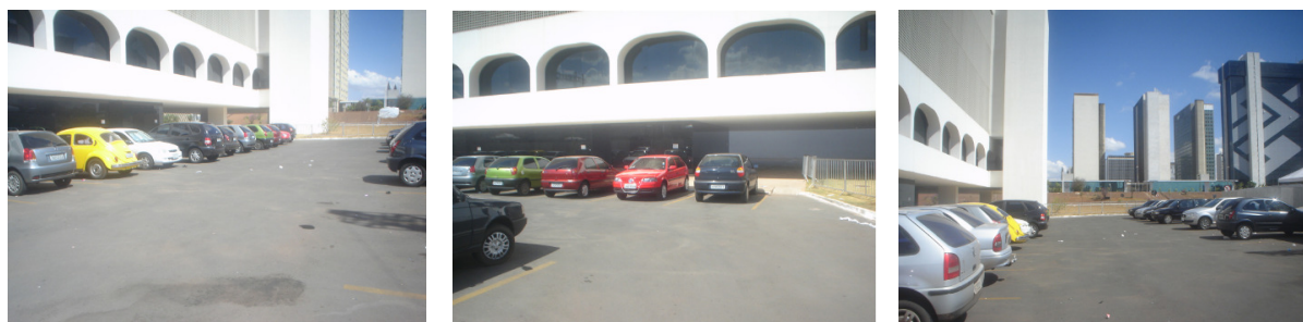
Ilustração 49 – Fotos do estacionamento da Biblioteca Nacional sem a sinalização recomendada pela norma técnica.
