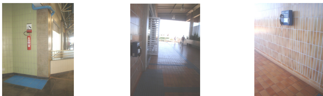
Ilustração 19 – Fotos dos obstáculos suspensos (extintores e orelhões) na Estação de Metrô Terminal Ceilândia com e sem sinalização de piso.
