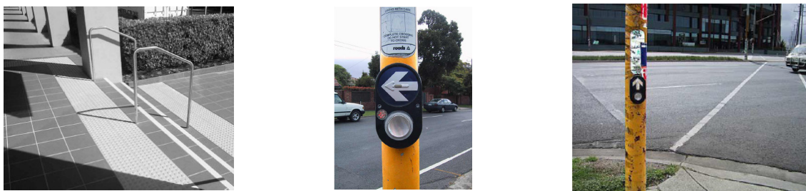
Ilustração 2 – Fotos de piso tátil e APS instalados em área urbana de Sidney - Austrália.
