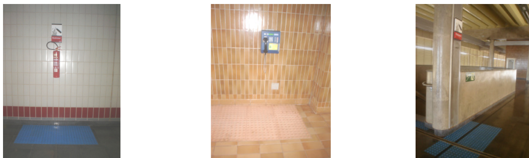
Ilustração 18 – Fotos dos obstáculos suspensos (extintores e orelhões) na Estação de Metrô Guariroba com sinalização de piso e até sem o obstáculo.
