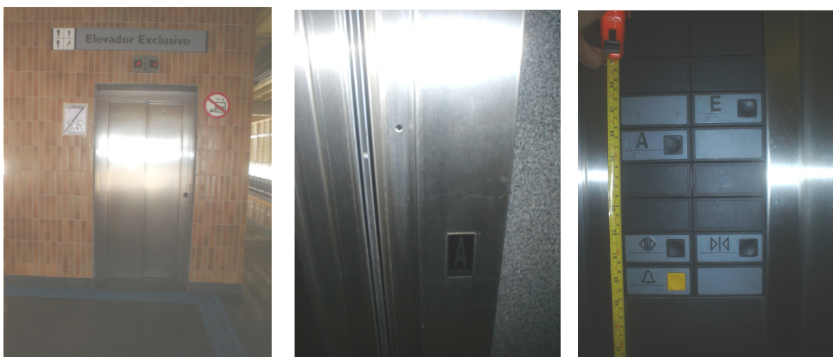
Ilustração 40 – Fotos dos elevadores da Estação de Metrô Guariroba sinalizados com piso tátil e com botoeiras com caracteres em braille.
