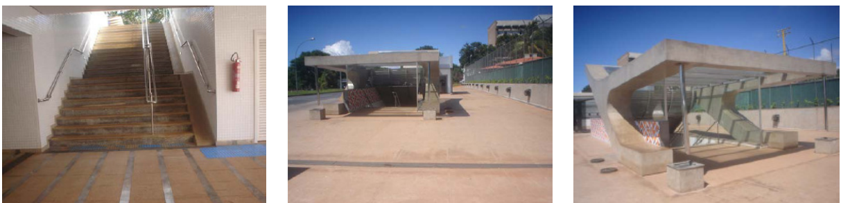
Ilustração 11 – Fotos dos acessos da Estação de Metrô 108 Sul.
