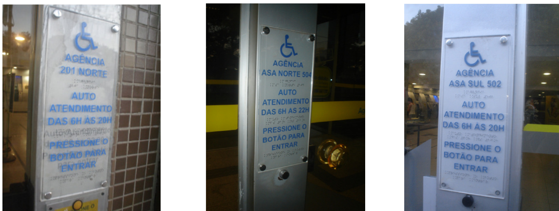
Ilustração 72 – Fotos das placas com sinalização tátil (caracteres em braille, textos e figuras em alto relevo) das agências 201 Norte, 504 Norte e 502 Sul, respectivamente.
