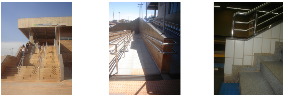
Ilustração 29 – Fotos dos corrimãos e guarda-corpos da Estação de Metrô Terminal Ceilândia.
