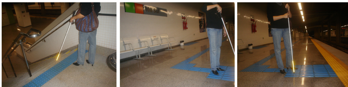
Ilustração 74 – Fotos da escada fixa e da plataforma de embarque com a sinalização tátil de piso, passeio acompanhado com Isabel na Estação de Metrô 108 Sul.
