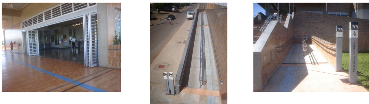
Ilustração 16 – Fotos dos acessos da Estação de Metrô Terminal Ceilândia sem a sinalização recomendada pela norma técnica.
