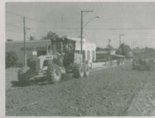
Os serviços de pavimentação asfáltica são supervisionados por engenheiros
