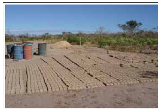
Figura 52. Alvenaria produzida para a construção da casa de farinha na comunidade Nova Jerusalém. Foto: Autora, 2007.
