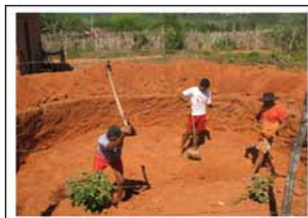
Figura 19. Projeto de cisterna em construção. Foto: Autora, 2006.
