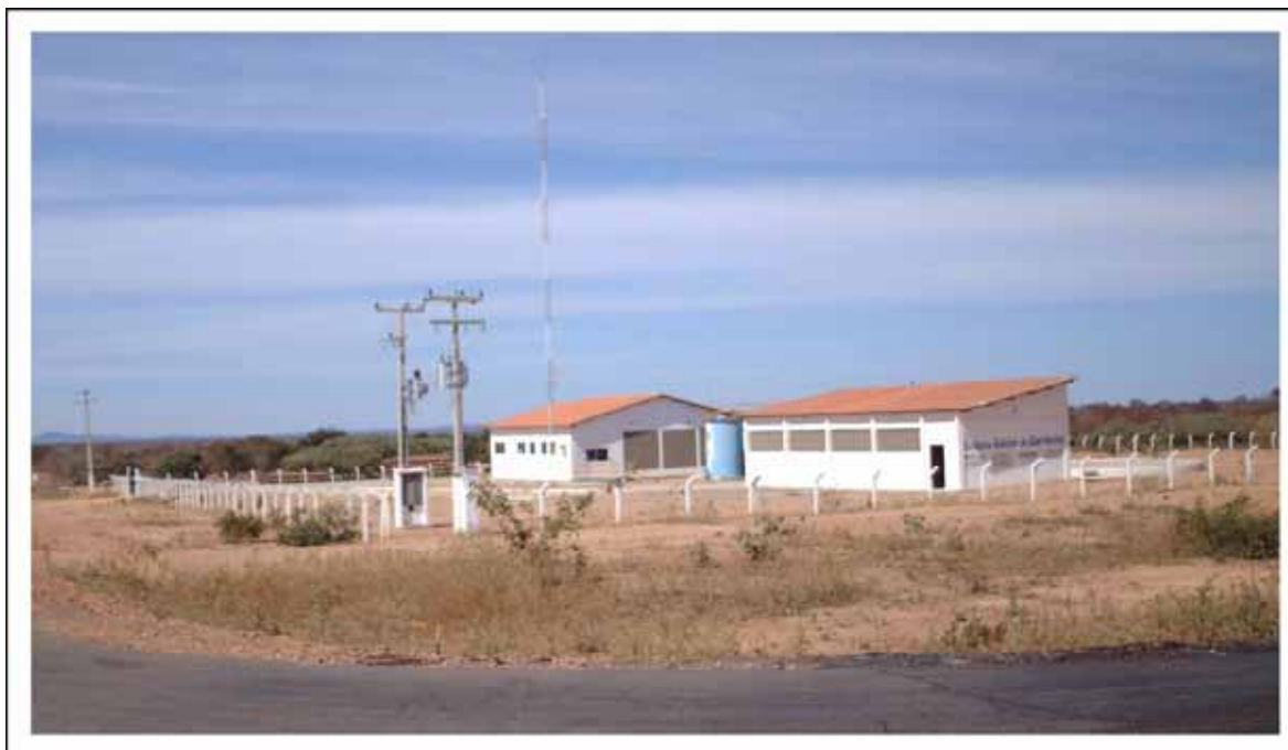
Figura 25. Casa de máquinas do Sistema Adutor do Garrincho. Foto: Autora, 2007.
