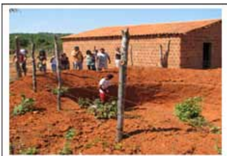
Figura 18. Trabalhadores em atividade para construção de cisterna. Fonte: Autora, 2006.
