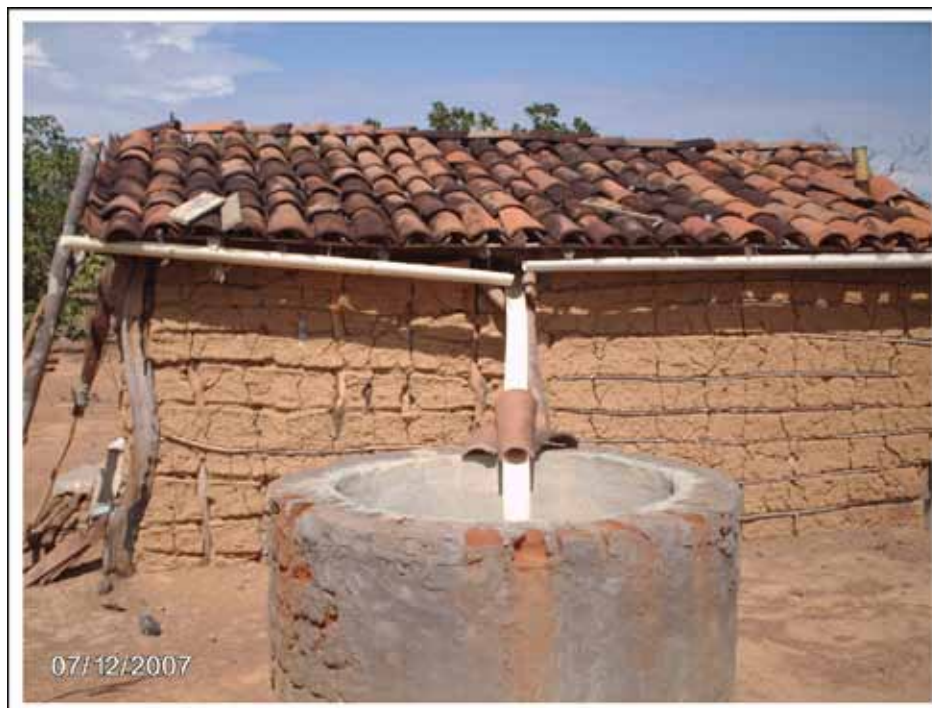
Figura 73. Cisterna em residência de morador da Gleba II. Foto: Autora, 2007.
