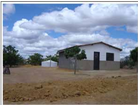
Figura 56. Vista da estrutura de uma das casas da comunidade Novo Zabelê. Foto: Autora, 2007.
