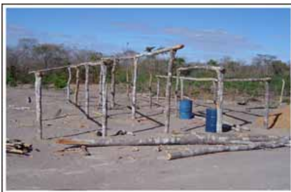
Figura 51. Estrutura da futura casa de farinha da comunidade Nova Jerusalém. Foto: Autora, 2007.
