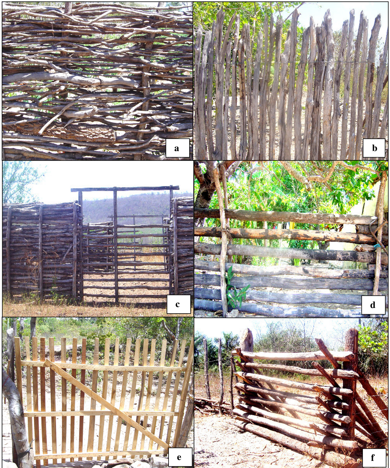
Fig. 2. Cercas portões utilizados pela população do município de Cocal, Piauí: a - cerca de cama, b - cerca de fachina, c - cerca amarrada, d - cerca de passagem, e - portão, f - porteira.
