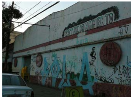
Fachada do galpão usado como estacionamento, localizado na Rua Washington Luiz.
