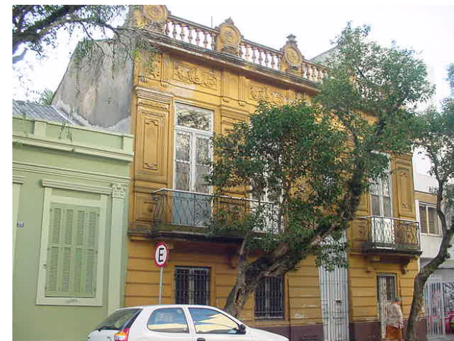
Casarão eclético de platibanda ornamentada com medalhões e balaústres em módulos ritmados de acordo com as aberturas. Reforçando a demarcação de acesso, a porta principal rompe a linha horizontal que divide os níveis na fachada.
