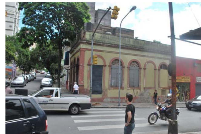
Edificação do princípio de século XX, tipologia tipicamente comercial em estilo neoclássico, com portas e janelas em arco pleno, na Rua Duque de Caxias, esquina com Gen. Bento Martins.
