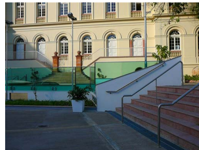
Fachada dos fundos do Teatro São Pedro, vista a partir do terraço central onde se localiza o restaurante.
