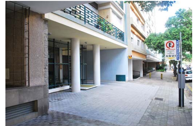
Edifícios residenciais modernos na Rua Duque de Caxias, alinhados pelos novos recuos frontais. A sequência acima mostra a vista das inúmeras áreas de acesso dos edifícios com os pilotis gradeados.
