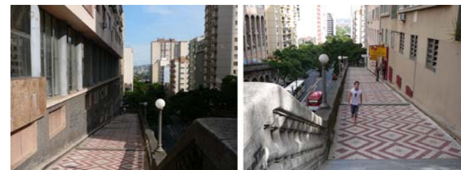
Escadarias do viaduto na direção da zona sul de Porto Alegre.
