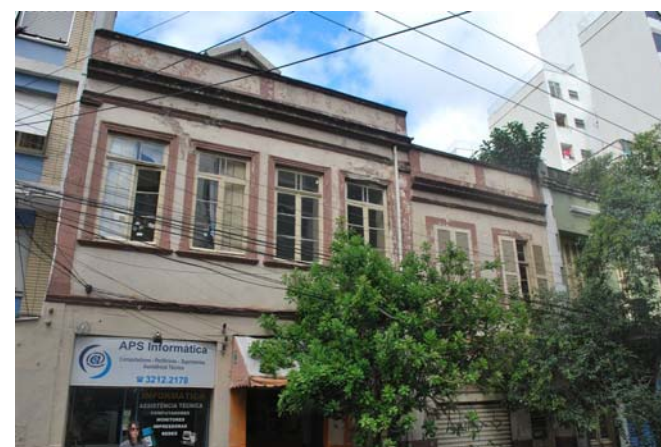
Casas com platibanda e frisos neoclássicos. Ao nível térreo, as aberturas encontram-se descaracterizadas. Fonte imagem: Foto Cristiano Kunze, 2009.
