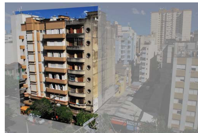
Acima, edifícios proto-modernos, na Rua Fernando Machado junto à esquina com a Avenida Borges de Medeiros.
