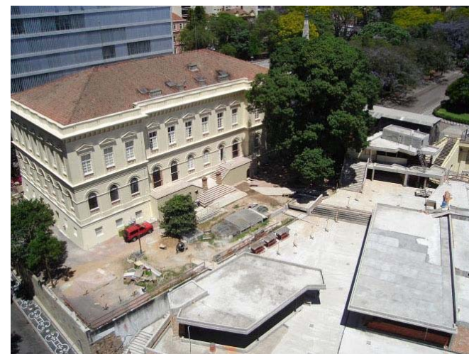
Vista aérea do local durante as obras.
