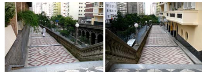
Escadarias do viaduto na direção do centro da cidade.
