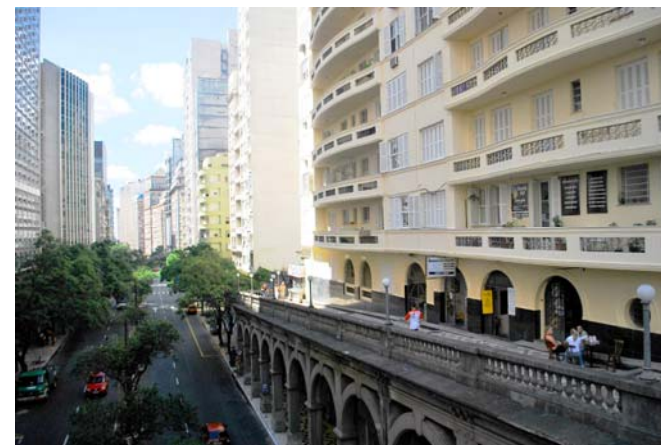
Vista do Viaduto Otávio Rocha desde a Rua Duque de Caxias, na direção norte.
