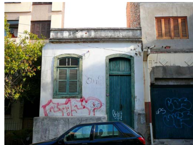
Casa colonial de porta e janela localizada na Rua Demétrio Ribeiro - único exemplar da zona que preservou as aberturas com arco abatido. O telhado original foi modificado com a construção da platibanda na fachada, que passou a ser uma exigência das leis do município ainda no século XIX. Fonte imagem: Foto da autora, 2009.
