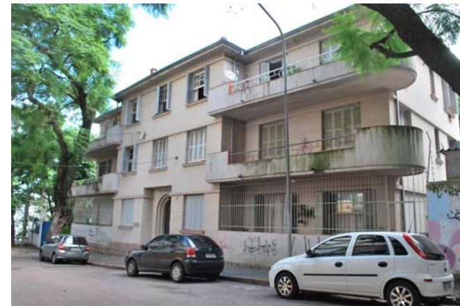
Exemplar proto-moderno localizado na Rua João Manoel, próximo à escadaria que desce até a Fernando Machado. A entrada é centralizada neste caso, em que o lote possui ampla testada. A composição de fachada e volumetria é simétrica, com eixo traçado no alinhamento do acesso principal.
