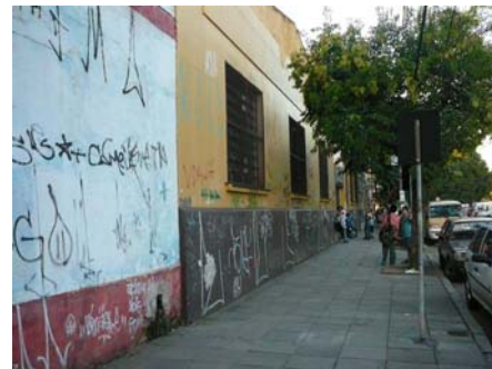
Vista do passeio público na Rua Washington Luiz, junto ao galpão de estacionamentos.
