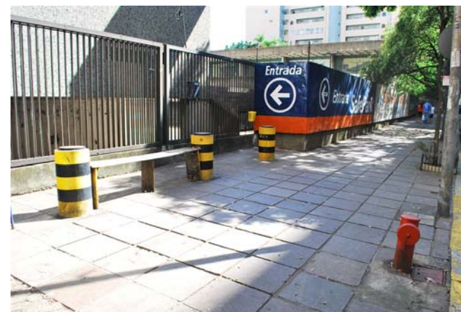
Vista do passeio público em frente ao terreno fechado com edificações inacabadas na Duque de Caxias.
