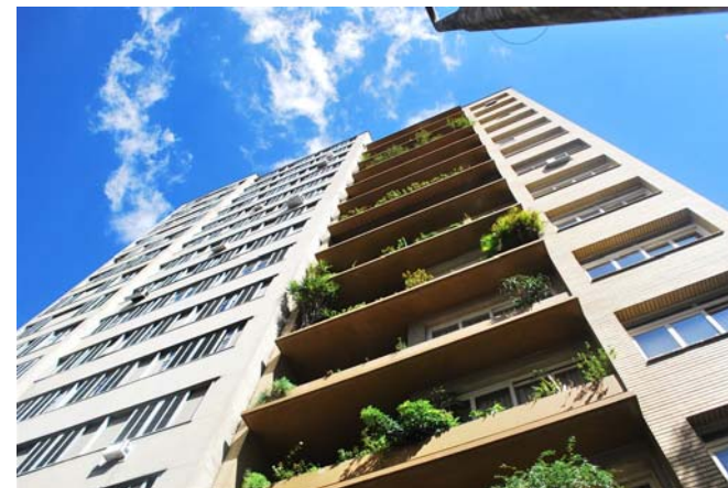
Edifícios residenciais na Rua Duque de Caxias, com recuos frontais e isentos de recuos laterais, posteriores ao Plano de 1959.
