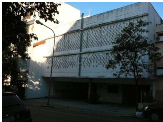
Vista da edificação garagem na Rua Duque de Caxias, quase na esquina com a Gen. Cipriano Ferreira.
