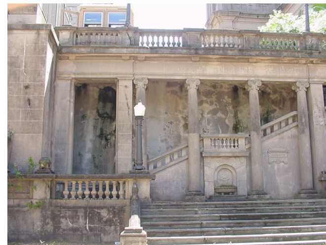
Patamar intermediário da escadaria entre a Catedral e o Palácio Piratini. O local pertence à Cúria Metropolitana e dá acesso a um espaço que ocasionalmente é alugado para eventos privados.
