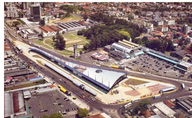
Vista aérea - Terminal Triângulo na Av. Assis Brasil - Terceira Perimetral na zona norte de Porto Alegre.
