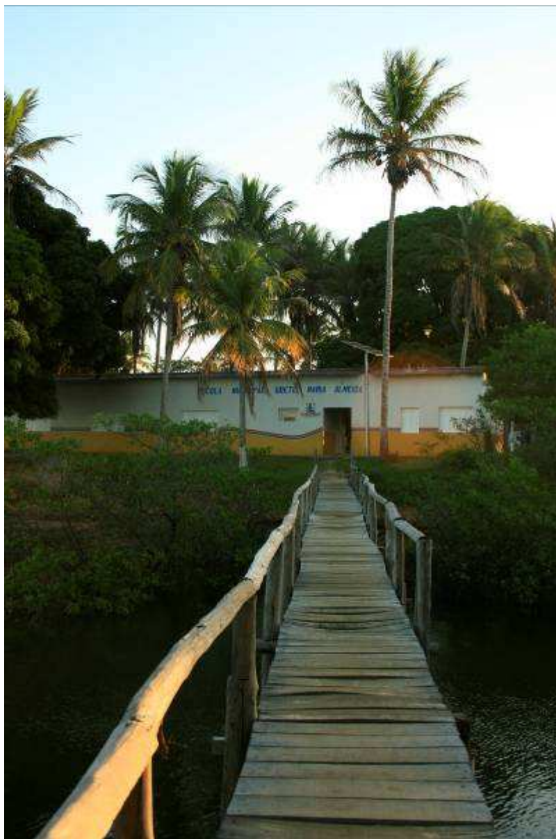
FIGURA 13 – Escola Municipal localizada no manguezal, às margens do rio Caribé (maio/2008 – fotografia da autora).
