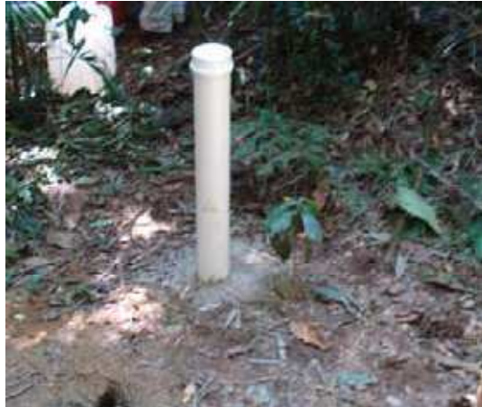
Figura 11. Poço de monitoramento do lençol freático
